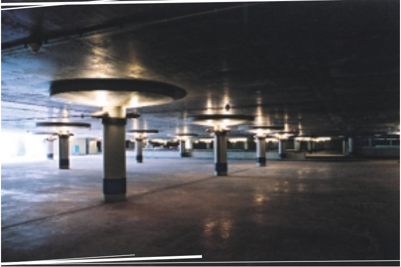
De nieuwe parking onder het Martelarenplein.
