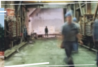
Bouw van de tunnel onder het station Antwerpen-Centraal.
