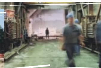
Construction du tunnel sous la gare d'Anvers-Central.
