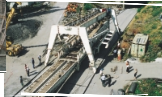
Pont de transfert pour réalisation du radier.
