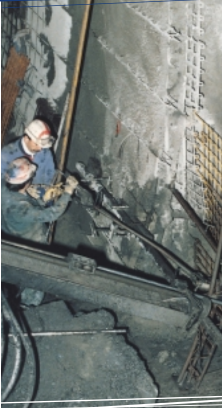
Mise en place de cintres réticulés en stross et de boulons passifs
