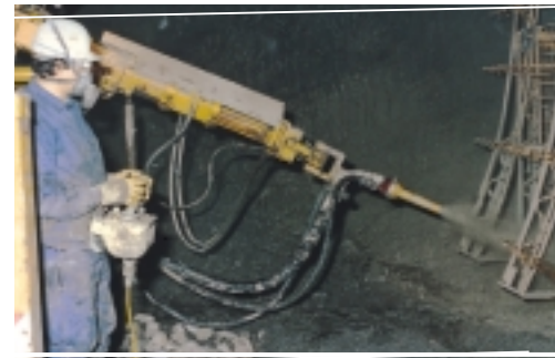
Mise en place de béton projeté à l'aide d'un robot.
