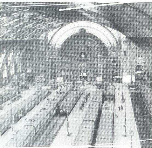
Antwerpen-Centraal werd gebouwd door de Brugse architect Louis De la Censerie in de periode 1898-1905 en was vóór de werken een kopstation met 10 doodlopende sporen.
