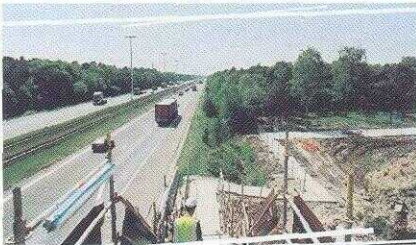
De werken voor de aanleg van de hsl tussen Antwerpen en de Nederlandse grens zijn in oktober 2000 gestart. Eind 2005 zal de nieuwe spoorlijn voltooid zijn.
