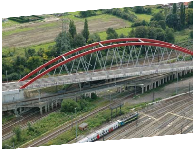
Het viaduct van Brussel-Noord, dat op 1 december 2006 werd ingewijd
