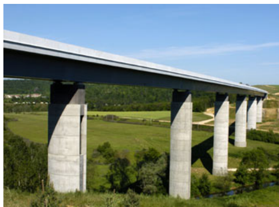
Viaduc de Jaulny (54) – LGV Est – Juin 2005
