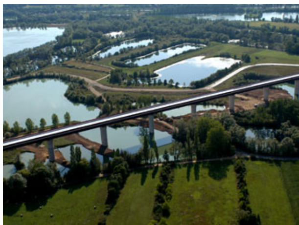
Viaduc de la Moselle (54) – LGV Est – Septembre 2005
