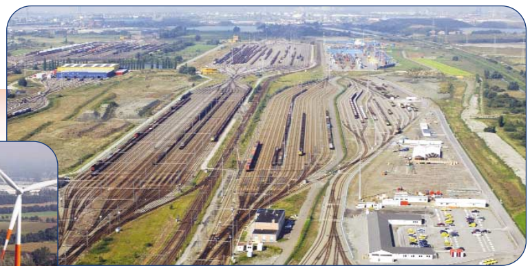
Werktreinen zullen vanuit het rangeerstation Antwerpen-Noord via het werkspoor materiaal aanvoeren.
