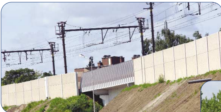
Het vier kilometer lange tracé van het werkspoor bundelt maximaal met de huidige goederenlijn.
