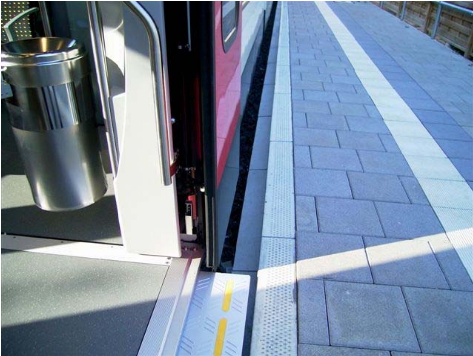
Photo 4. Guidage tactile et surfaces de guidage au bord d'un quai
