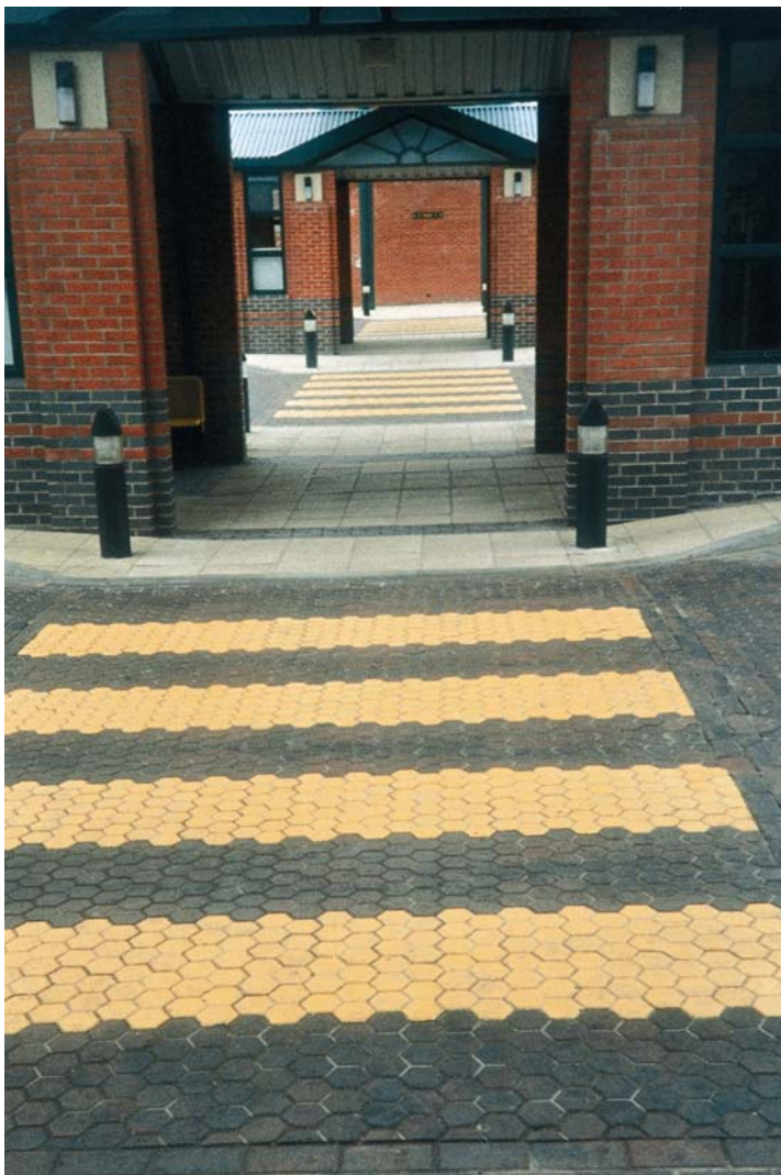
Photo 6. Une voie piétonne clairement identifiée, avec bordures de trottoir abaissées, dans une gare routière
