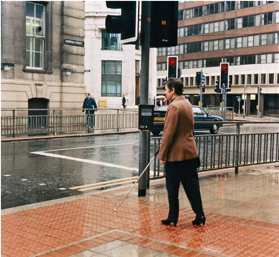
Photo 3. Les surfaces tactiles sont indispensables pour signaler les risques aux personnes non-voyantes et aux déficients visuels
