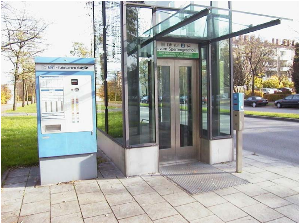
Photo 8. Accès au métro par ascenseur, Munich
