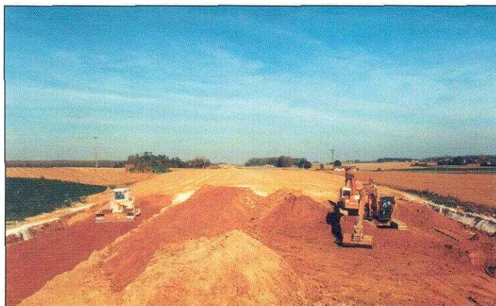
Vue depuis la culée n°2 du viaduc d'Arbre - direction Bruxelles
