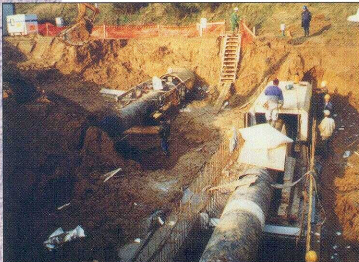
Coffrage du cadre autour de la conduite Distrigaz
