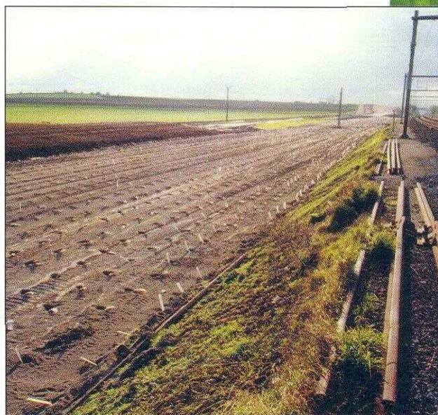
Horizon filtrant et drains verticaux le long de la ligne 94 - vue vers la frontière française
