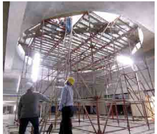
De dakkoepel van Brussel-Centraal (op de foto nog in aanbouw) zorgt voor een heldere lichtinval in de ondergrondse verbinding tussen de ingang Magdalena, de ingang Kunstberg en het winkelcentrum.
