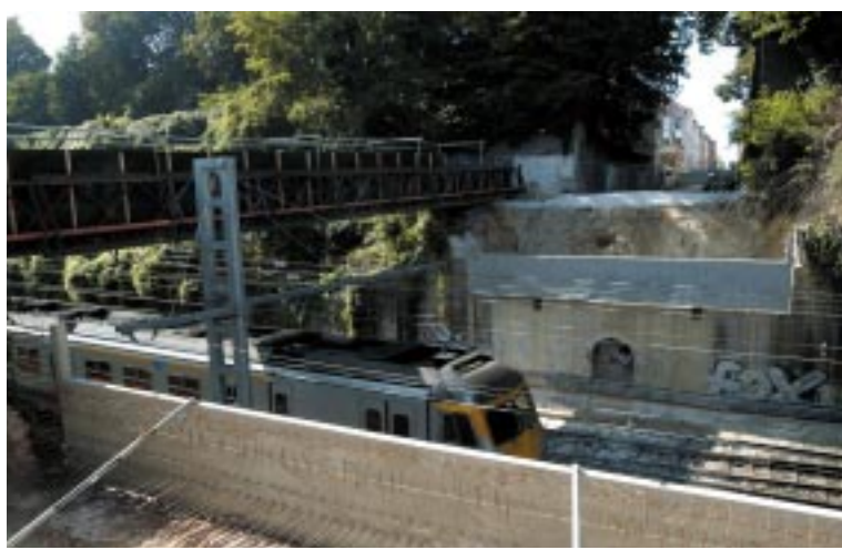
Een voetgangersbrug zorgt ervoor dat voetgangers en fietsers de spoorlijn kunnen oversteken tijdens de bouw van de nieuwe brug voor de Viaductstraat.
