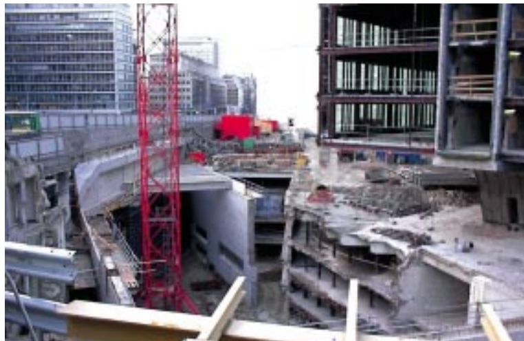
7 Een deel van het nieuwe station Brussel-Schuman is al gebouwd, met name het gedeelte onder het Berlaymontgebouw. De werken gebeuren terzelfdertijd als de renovatie van dat gebouw.
