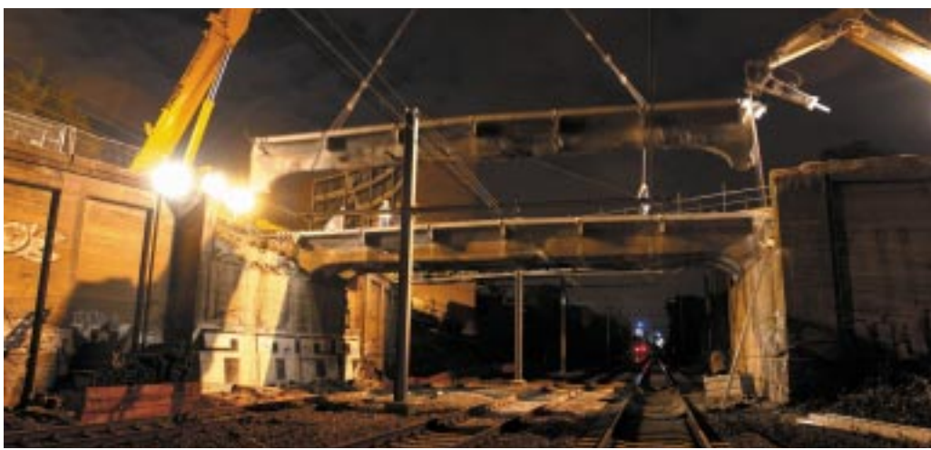
Afbraak van de brug aan de Rodinlaan.
