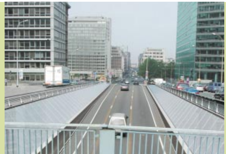
2 Aan beide kanten van de toegangshelling van de tunnel aan de Wetstraat komen glazen panelen zodat het daglicht kan binnenvallen in het nieuwe station.
