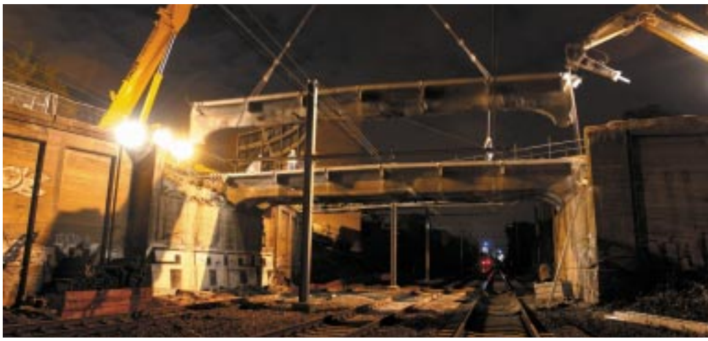
Démolition du pont de l'avenue Rodin.
