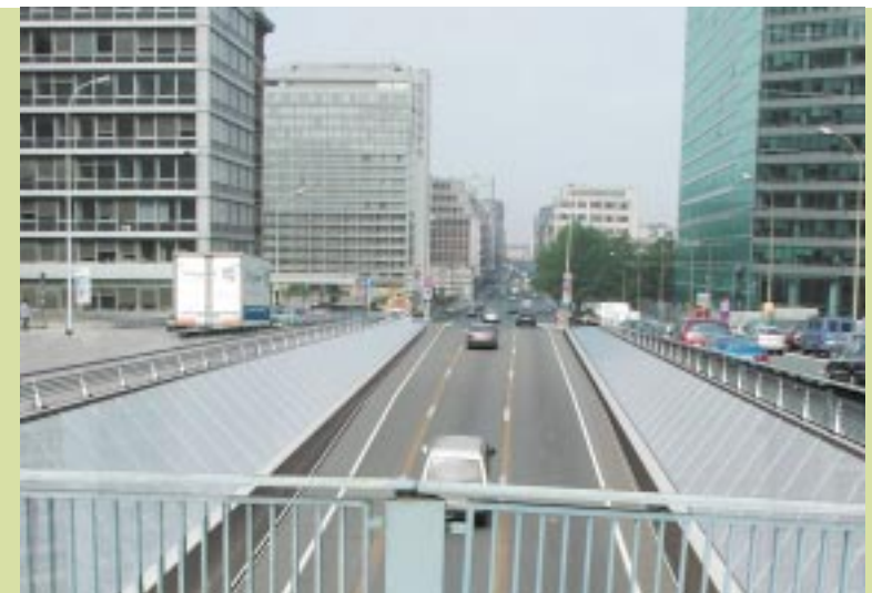
2 De part et d'autre du tunnel routier débouchant sur la rue de la Loi, des baies vitrées laisseront entrer la lumière à l'intérieur de la nouvelle gare.
