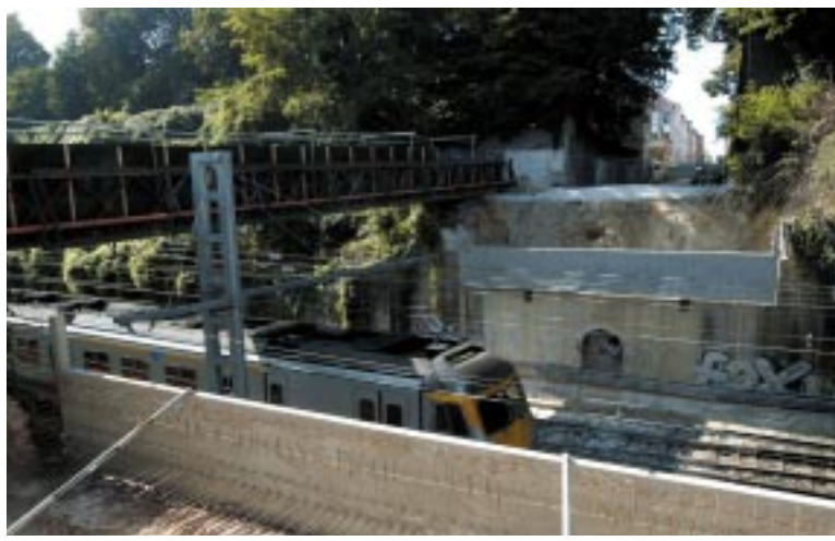
Une passerelle permet aux piétons et aux cyclistes de franchir la ligne de chemin de fer pendant la construction du nouveau pont de la rue du Viaduc.
