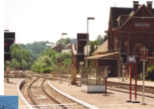
Het nazicht en onderhoud van de sporen bepaalt in hoge mate de verkeersveiligheid van het treinverkeer.
