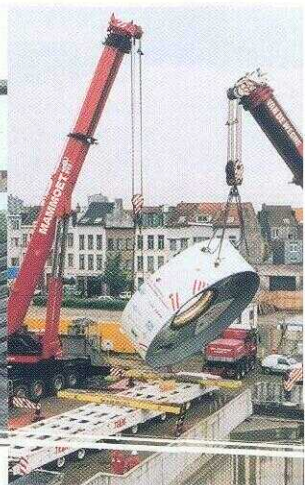
Grote kranen laten het boorschild neer in de vertreschacht, waarna de montage kan beginnen.
