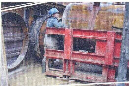
Van april tot juli 2002 zijn vanuit de persput in de Viséstraat een twintigtal buizen geperst onder de huizen richting bouwput in de Sint-Jobstraat.
