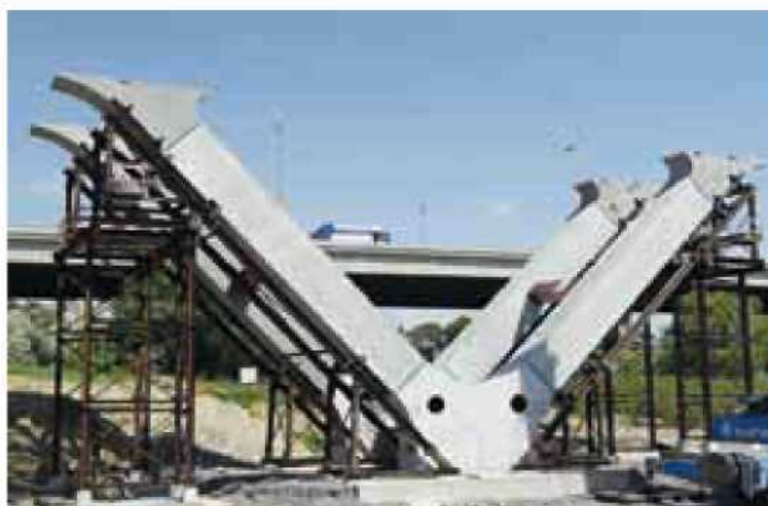
▲ Bouw van de José-viaduct langs de hogesnelheidslijn nr. 3
