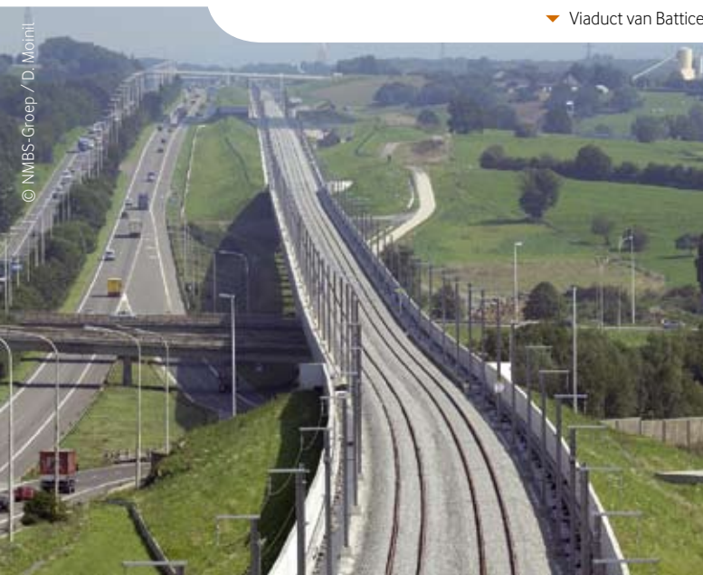
▼ Viaduct van Battice
