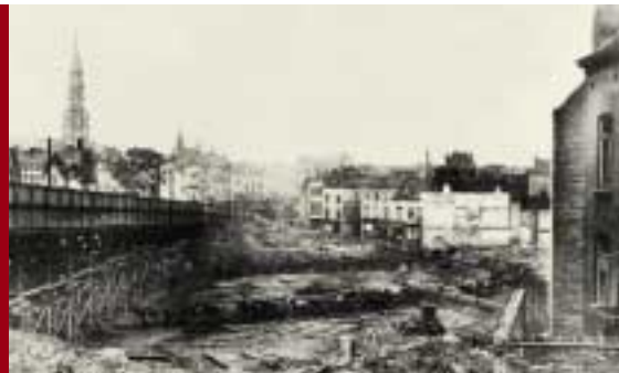
Démolition du quartier de la Putterie, à hauteur de la rue Jour et Nuit, vers 1912. Photo: Archives de la ville de Bruxelles (C3704)
