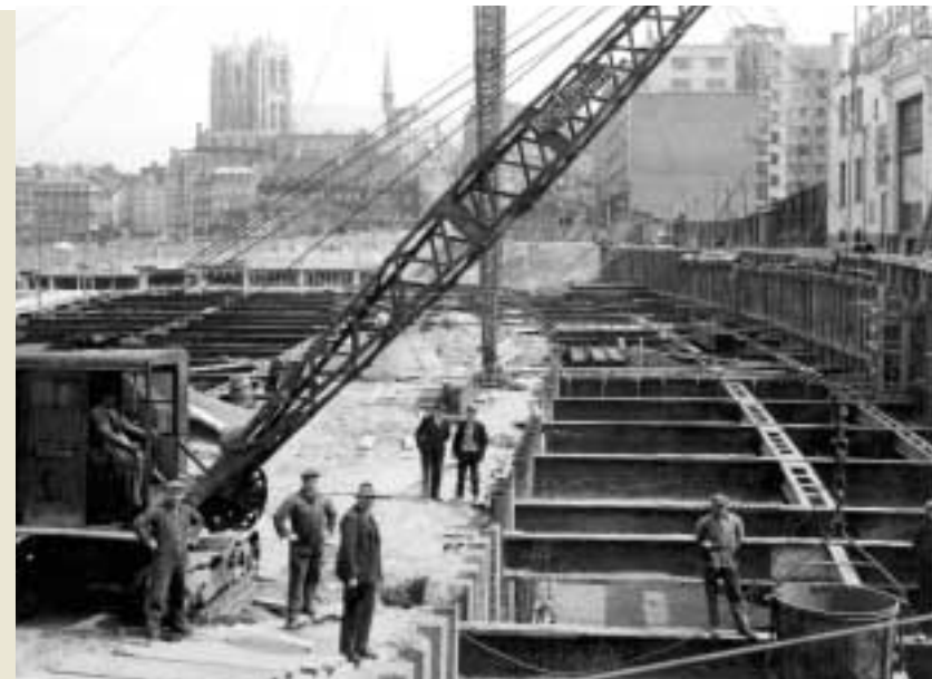
La réalisation de la Jonction Nord-Midi, à la fin des années 1930, entrainé dans le cadre de la politique des grands travaux publics permettant de lutter contre le chômage. Photo: Cercle d'Histoire et de Documentation de Saint-Gilles, Sergysels, collection P. Pastiels
