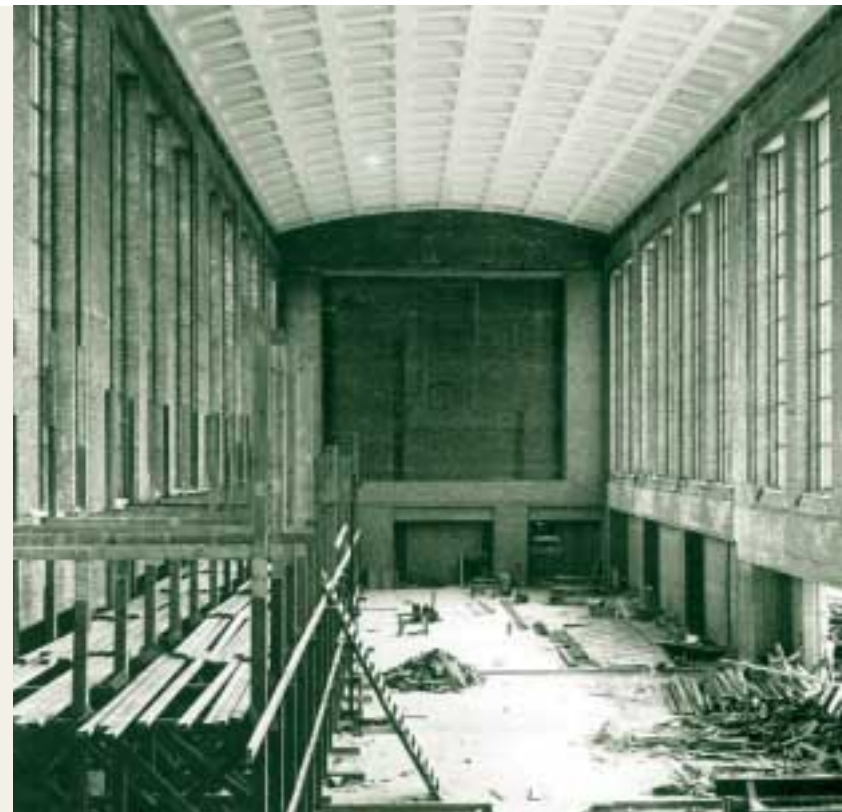
L'immense salle des guichets de Bruxelles-Nord en plein chantier.
