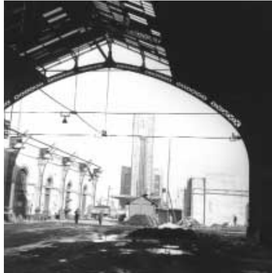
Het oude en het nieuwe Noordstation
