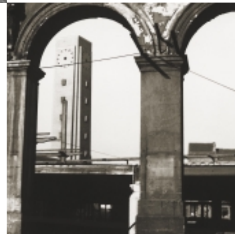
Afbraak van het Zuidstation jaargang 1864 en bouw van het zakelijke station van de jaren vijftig. De toren zal in 1992 opnieuw verdwijnen voor de vierde vernieuwing van het station.
