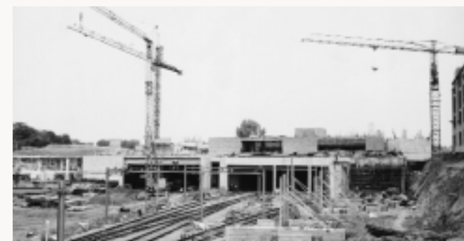
Bouw van de spoorlijn naar Louvain-La-Neuve, in die periode een vernieuwende vorm van stedenbouwkunde.
