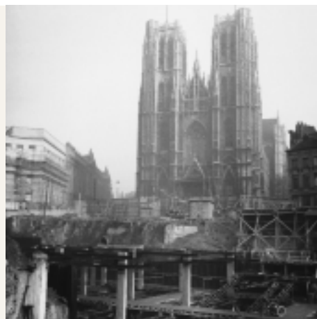
Bouw van de Noord-Zuidverbinding ter hoogte van de Sint-Michiels- en Sint-Goedelekathedraal.
