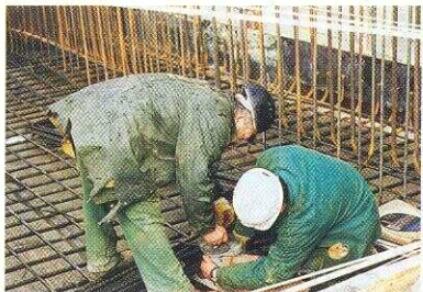
De uitrusting van de nieuwe stations en haltes zal aansluiten op de modernisering van de spoorlijn Brussel - Leuven
