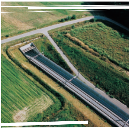
▲ Tunnel van Bierbeek
