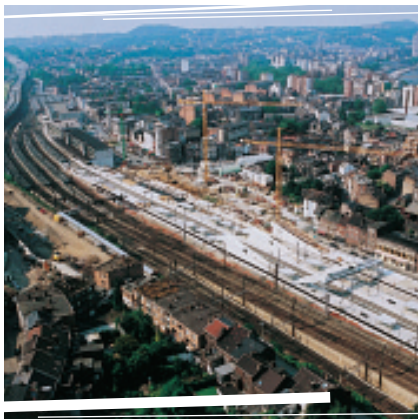
▲ De werken voor het station Luik-Guillemins gezien vanuit de lucht
