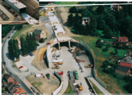
▲ Vaux-sous-Chèvremont: ingang van de tunnel van Soumagne
