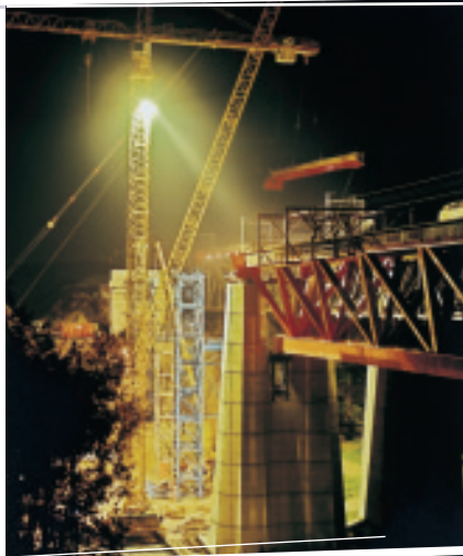
▲ Vernieuwingswerken aan het viaduct van Hammerbrücke
