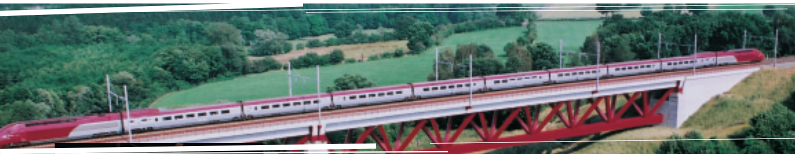
▲ Viaduct van Hammerbrücke
