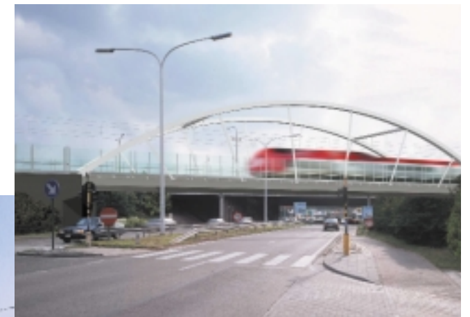
De Kleine Bareel krijgt een ultramodern viaduct met doorzichtige geluidsschermen.
