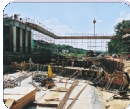
Bij de werken aan de bruggen over de E19 wordt er steeds voor gezorgd dat voetgangers en fietsers via een tijdelijke constructie de werken kunnen oversteken.
