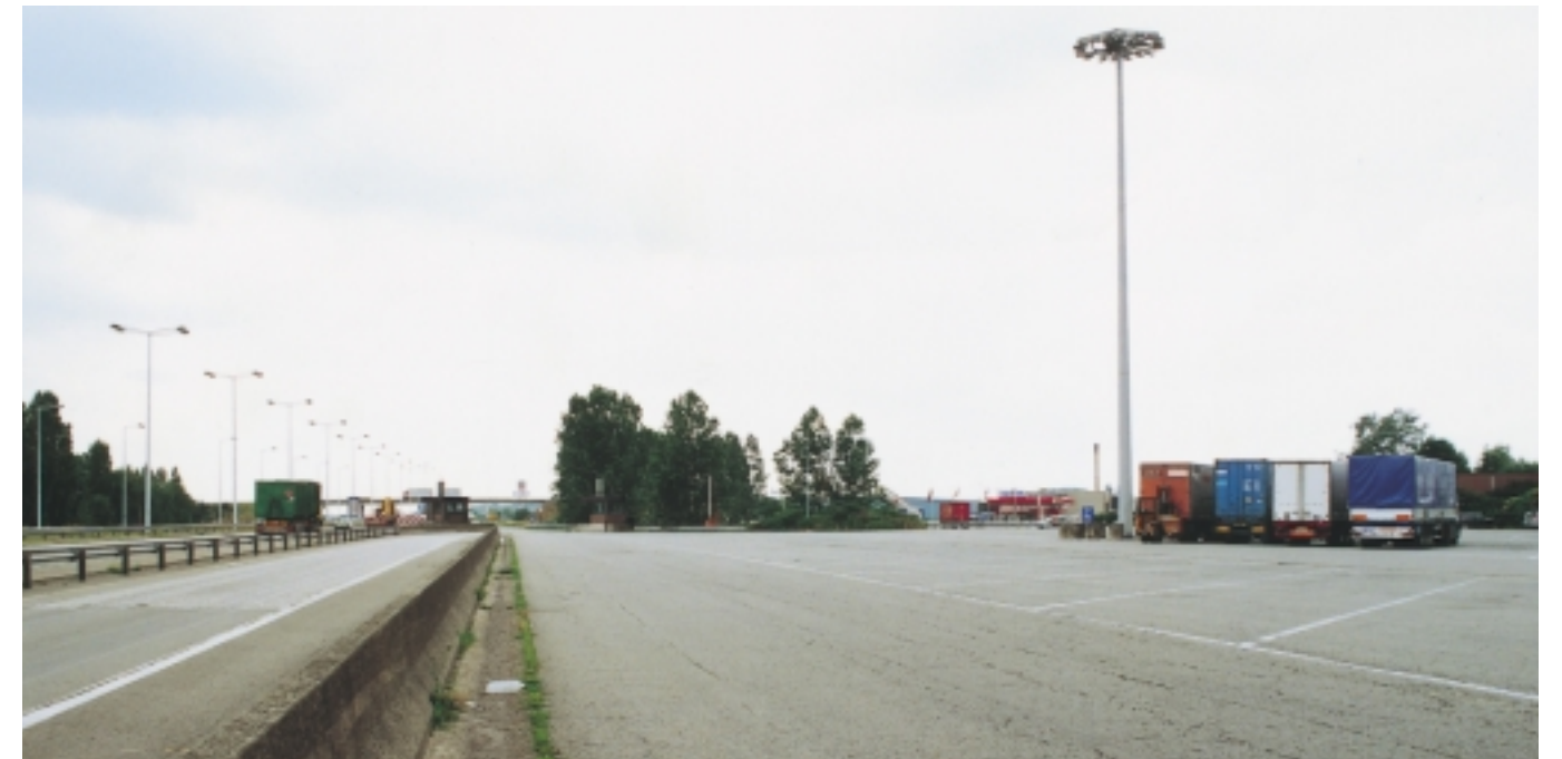
Om de aanleg van de hsl aan de Mosten mogelijk te maken, dient de autosnelweg een 40-tal meter te worden verplaatst in oostelijke richting.
