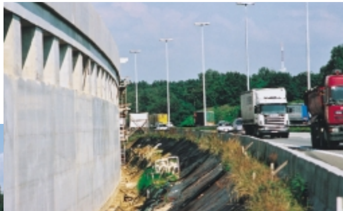
De koker doet dienst als geluidsscherm en zal het lawaai van de autosnelweg ter hoogte van het Peerdsbos met 10 decibel terugdringen.
