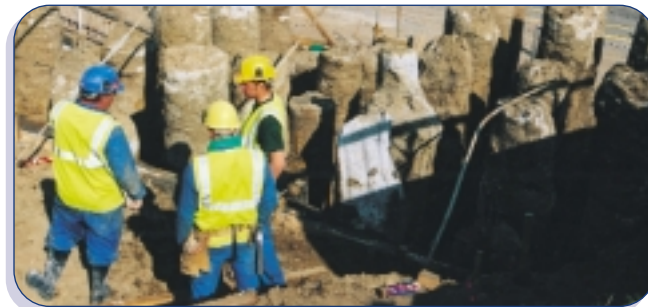
Wegens de zwakke ondergrond moeten de pijlers van het viaduct aan de Kleine Bareel extra worden versterkt.
