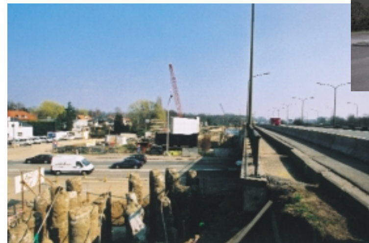
Het nieuwe viaduct komt ter hoogte van de Bredabaan vlak naast de E19 te liggen.
