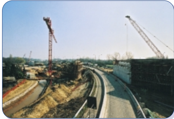
8 Ter hoogte van de Kleine Bareel wordt voor de hsl een viaduct gebouwd. De Laarsebeek werd voor de werken omgeleid.
