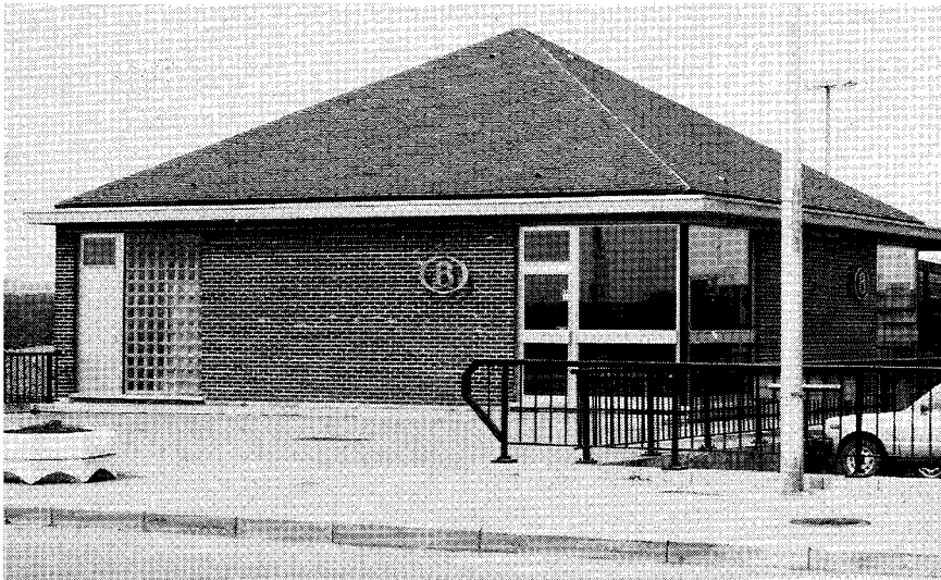
Het nieuwe stationsgebouw in Visé. (foto NMBS)
