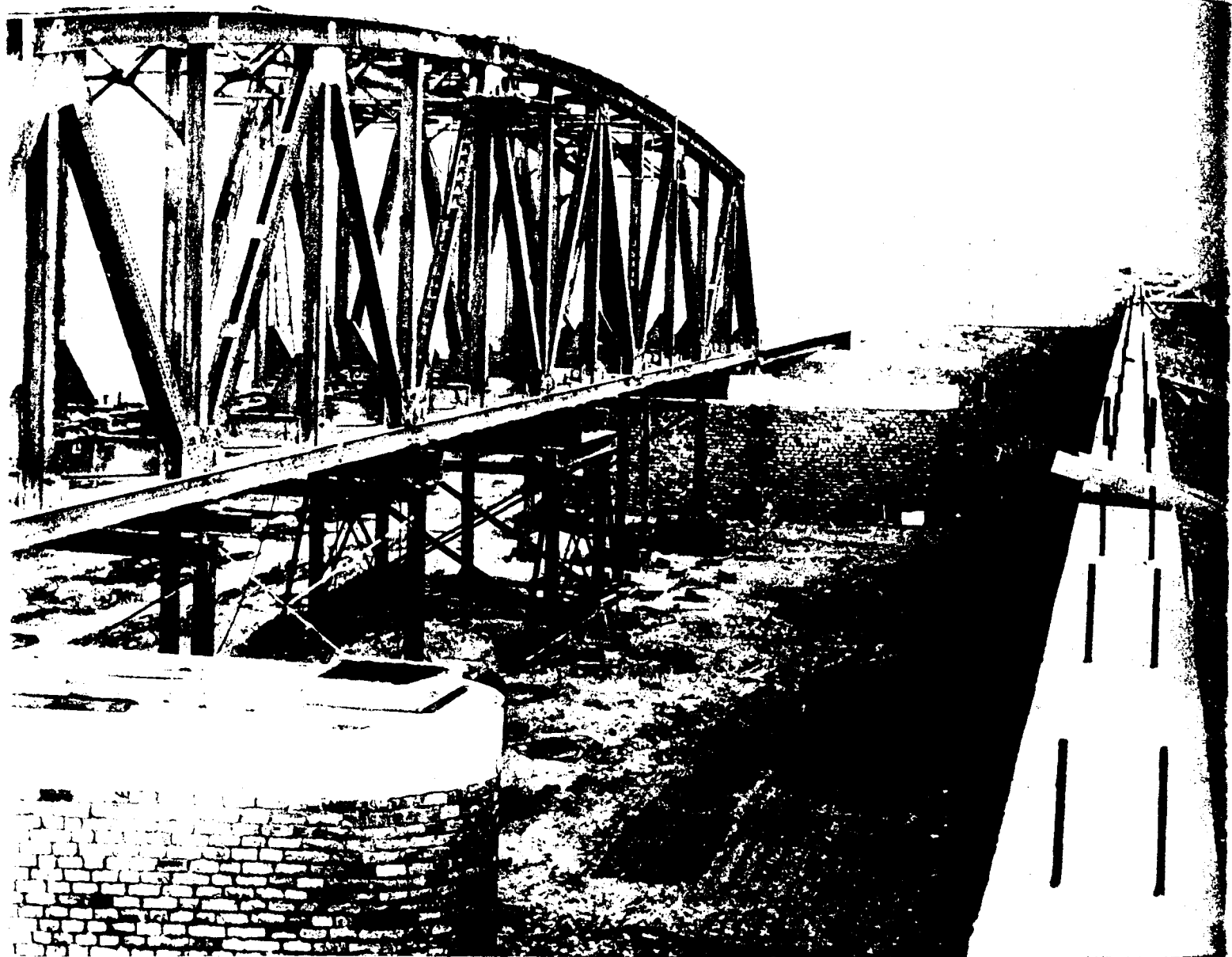
De spoorwegbrug over het nieuwe tracé van de Moervaart.
