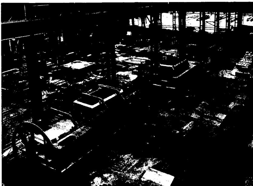
Fig. 5. Soudure des tenders sur gabarit tournant.
