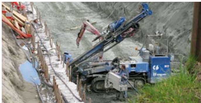
Een machine boort de trekankers onder een hoek van 35 graden.
