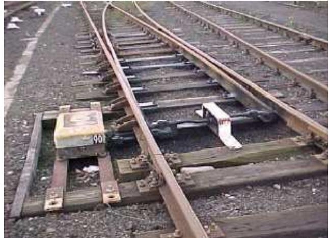
Van op afstand bediende wissel door middel van een elektrisch bedieningstoestel (wisselsteller).
