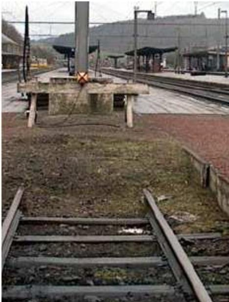
Een **doodspoor** wordt begrensd door een stootbok. De dekking van het uiteinde van het doodspoor wordt verzekerd door een merksein of een merkbord van een stootbok, geplaatst op de stootbok.
