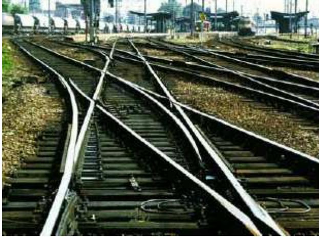
De **halve Engelse wissel** wordt geplaatst aan de kruising van twee sporen, met de mogelijkheid om langs één zijde van het toestel van het ene naar het andere spoor over te gaan.
