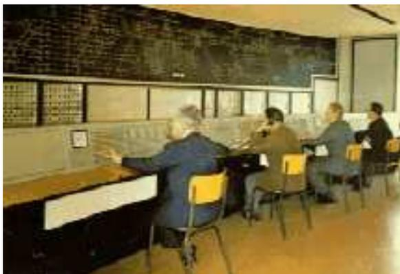
Vanaf 1950 verschenen de eerste al-relaisseinposten, waarbij de mechanische koppelingen waren vervangen door elektrische inklinkingen. Bij deze techniek werden er elektrische stroomkringen opgebouwd door middel van relaiscontacten en drukknoppen, een nieuwigheid die het werk van de seingevers aanzienlijk verlichtte. De eerste al-relaisseinpost werd geïnstalleerd te Zinnik door de firma Westinghouse.
