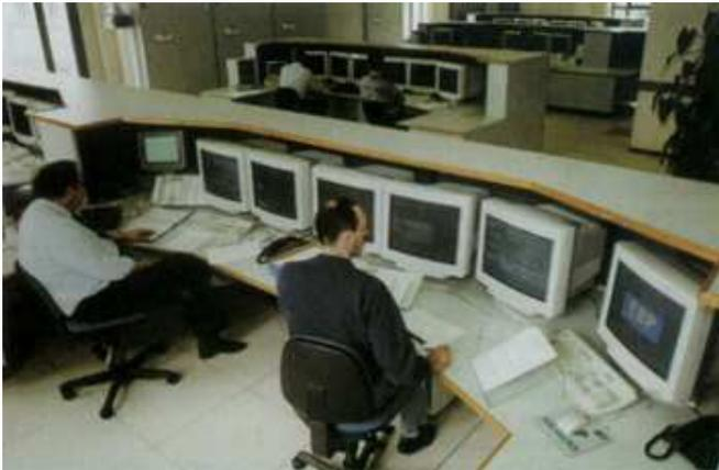
Met de doorbraak van de computer in de jaren '80 van vorige eeuw werd ook bij de spoorwegen gezocht naar middelen om een seinpost computergestuurd te gaan bedienen. Zo ontwikkelde de toenmalige NMBS, in samenwerking met een team van Siemens, de **elektronische bedieningspost (EBP)**.
