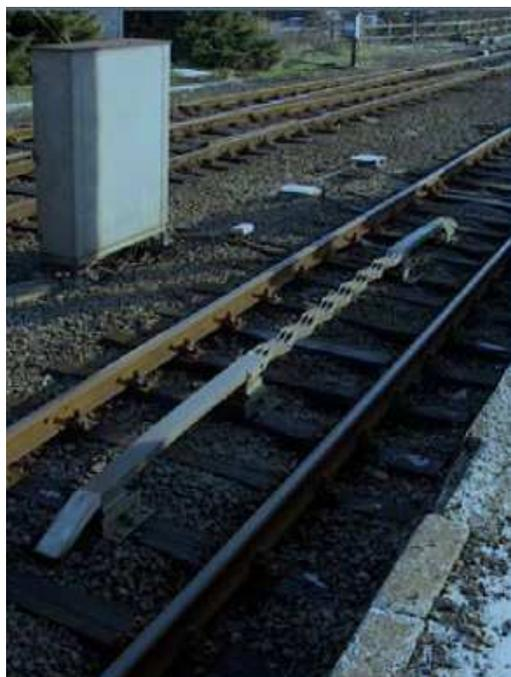
Het spanningsverschil tussen de naburige spoorstaaf en de krokodil hangt af van het seinbeeld waarmee zij verbonden is en laat toe om op het krachtvoertuig de seinherhalingsinrichting en de daarmee verbonden inrichtingen te bewerken.
