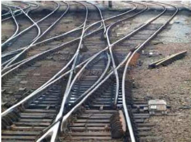
De **Engelse wissel** wordt geplaatst aan de kruising van twee sporen, met de mogelijkheid om langs beide zijden van het toestel van het ene naar het andere spoor over te gaan.
