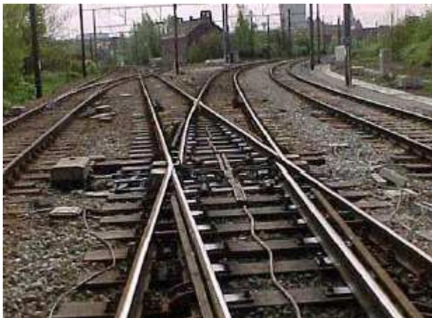
De **kruising met tongen** vervult dezelfde rol als een gewone kruising, maar ze bevat ter hoogte van het kruisstuk beweegbare tongen die zorgen dat er geen leemte ontstaat voor de geleiding van de wielkrans. Dit laat toe de kruisingshoek te verkleinen, zodat hogere snelheden kunnen worden bereikt. Kruisingen met tongen komen dan ook veel voor aan vertakkingen.
