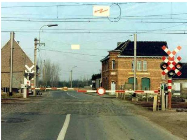
Een overweg van **tweede categorie** is voorzien van verkeerslichten en van twee gedeeltelijke slagbomen die zigzag aan beide zijden van de spoorweg zijn aangebracht en aan de rechterzijde van de openbare weg, ten opzichte van de richting die de gebruikers ervan volgen.
