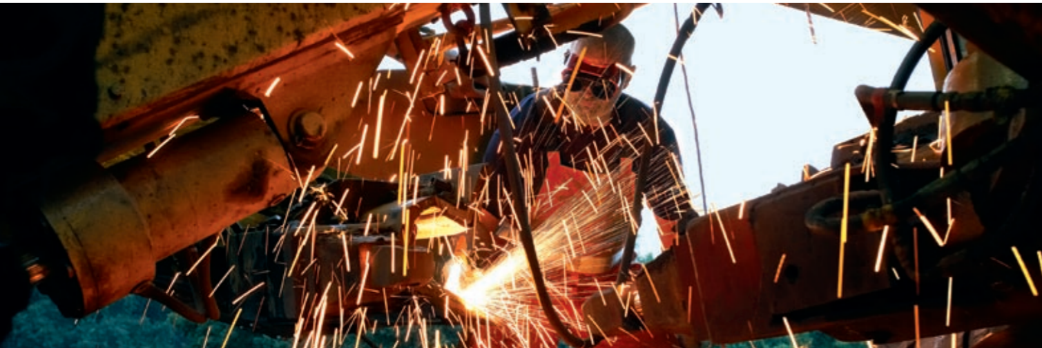
Die Informations- und Abstimmungsprozesse bei Baumaßnahmen waren Gegenstand intensiver Verhandlungen zwischen DB Netz und BNetzA.
