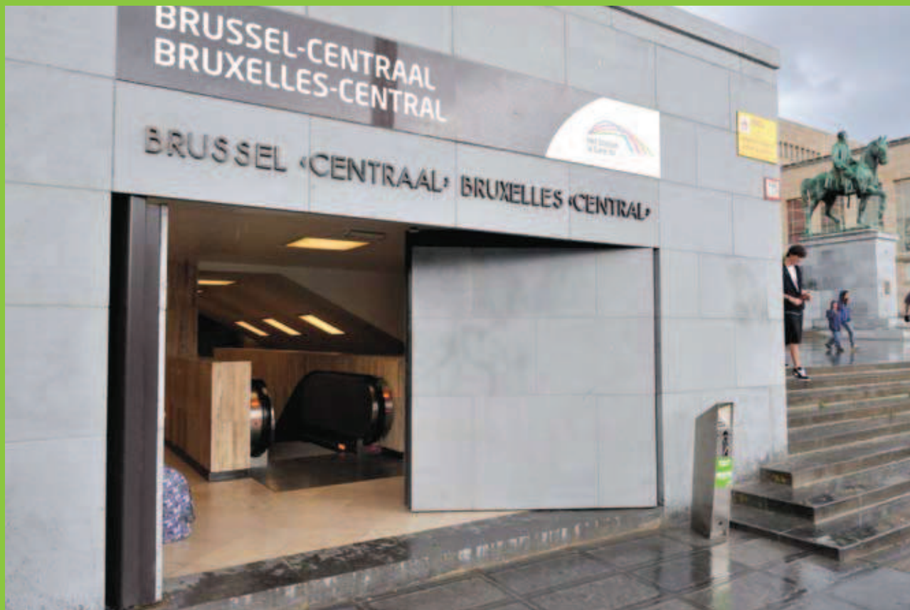
Ingang "Kunstberg" : de door is bekleed met "Vinalmontsteen".
