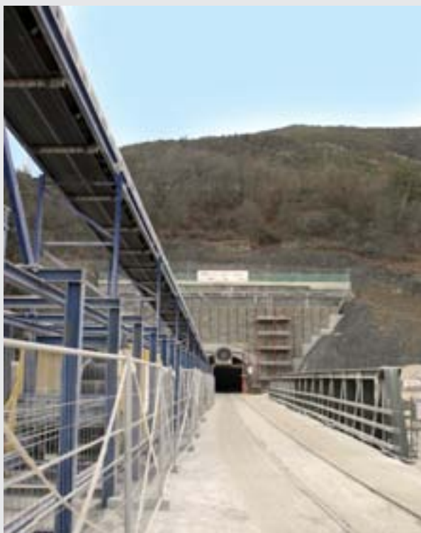
Foto 5 — Ingang van de proeftunnel voor het Brennertunnelproject bij Fortezza
