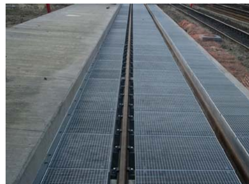
Exemple de station de ravitaillement
