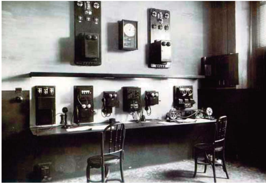
Mesa de comunicaciones de Lérida, donde se aprecia un conjunto de teléfonos, aparatos de cronometría y un telégrafo Morse
