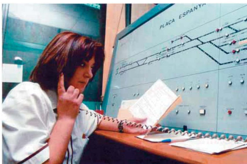
Factora de circulación en puesto de telefonía CTC Fuente: El camino del tren: 150 años de infraestructuras ferroviarias
