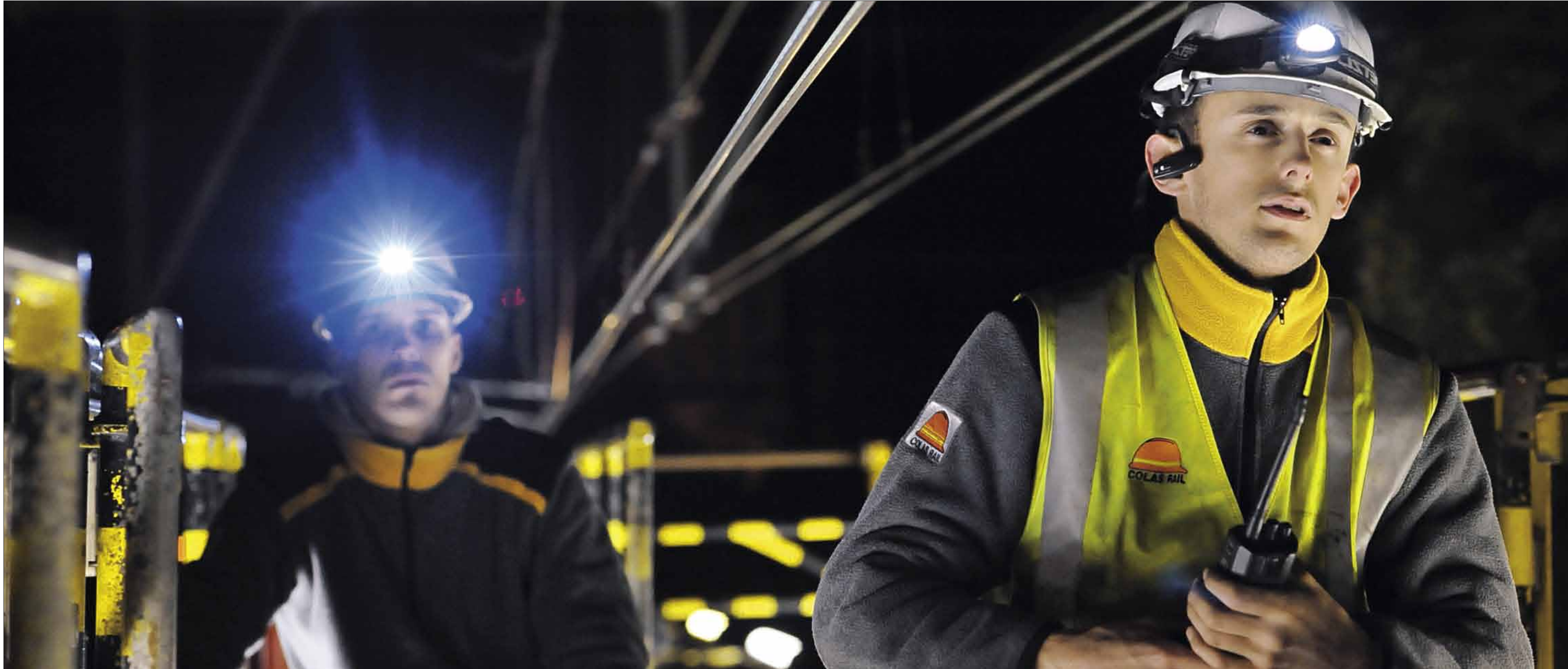
▲ Nachtwerken aan de bovenleiding
