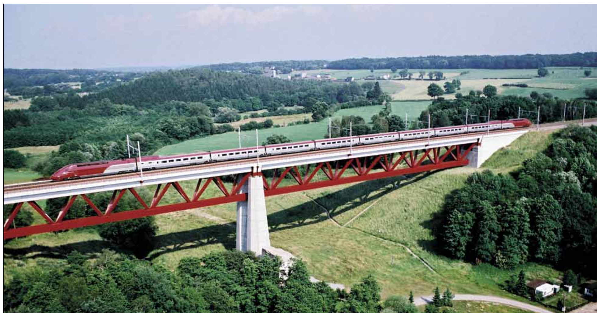
▲ ► Het viaduct van Hammerbrücke wordt ondersteund door een centrale steunpijler van 30 meter hoog
