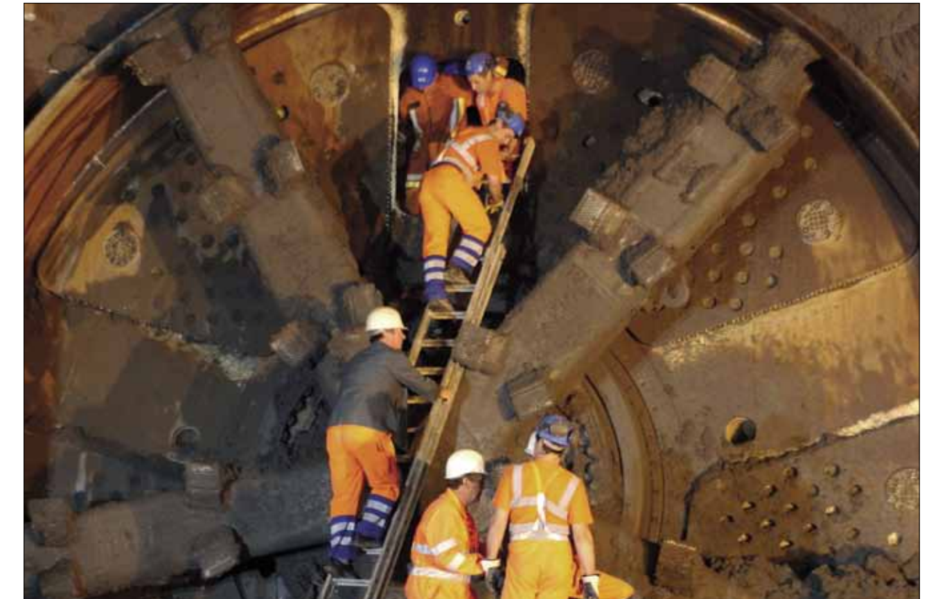
▲ ◀ Een gigantische tunnelboormachine, voorzien van twee boorschilden, groef de twee tunnelkokers
