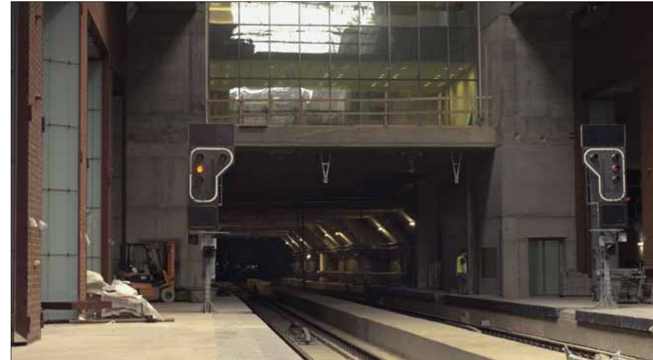
▲ De ingang van de tunnel onder het station van Antwerpen; 1,2 km verder komen de HST's opnieuw aan de oppervlakte ter hoogte van het Damplein.
