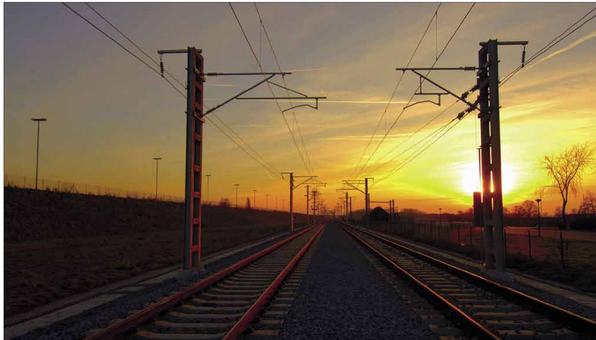
▼ Tussen de hogesnelheidslijn en de E19 verhindert een aarden muur dat wagens of vrachtwagens vallen bij een ongeval
