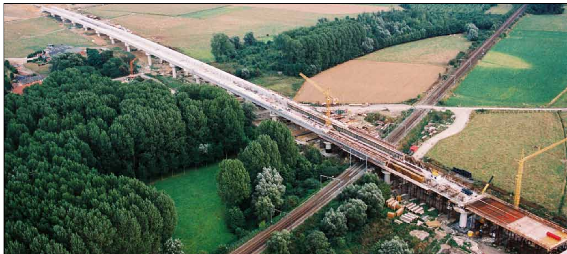
▲ Viaduct van Arbre: het langste spoorwegviaduct van Europa (2005 meter)
