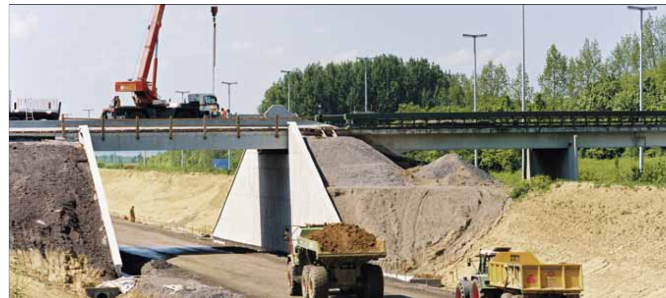
▼ ► Aanleg van de hogesnelheidslijn langs de E40 naar Luik
