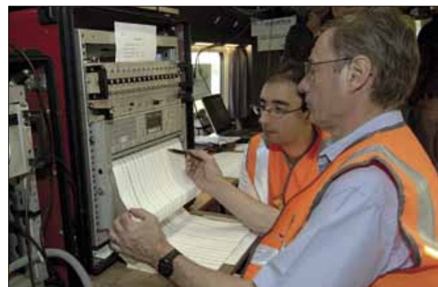
▶ De testritten worden uitgevoerd met HST's die zijn uitgerust met speciale meettoestellen
