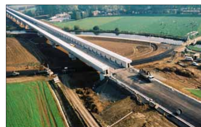
▲ Het viaduct van Arbre overbrugt de Scheldevallei
