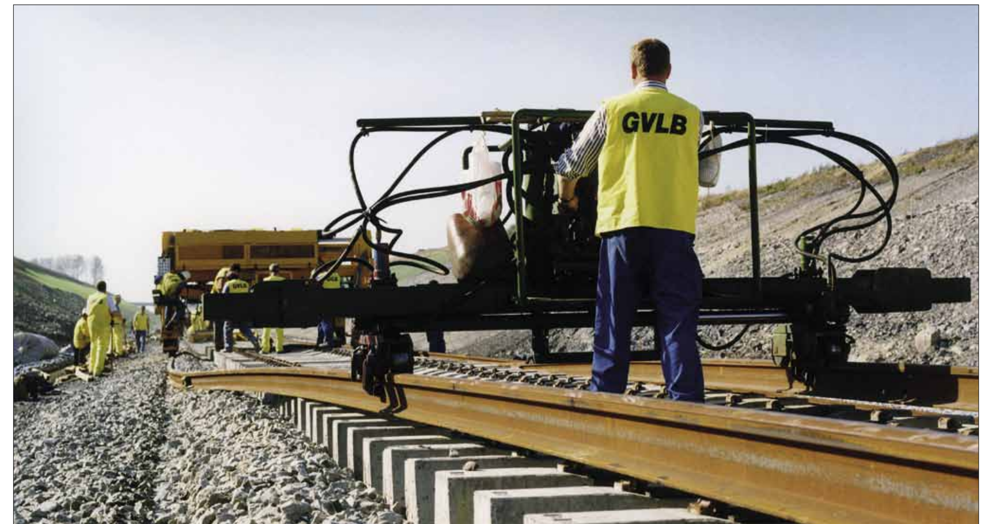
▼ Plaatsen van de langgelaste rails door de speciale Röbeltrain
