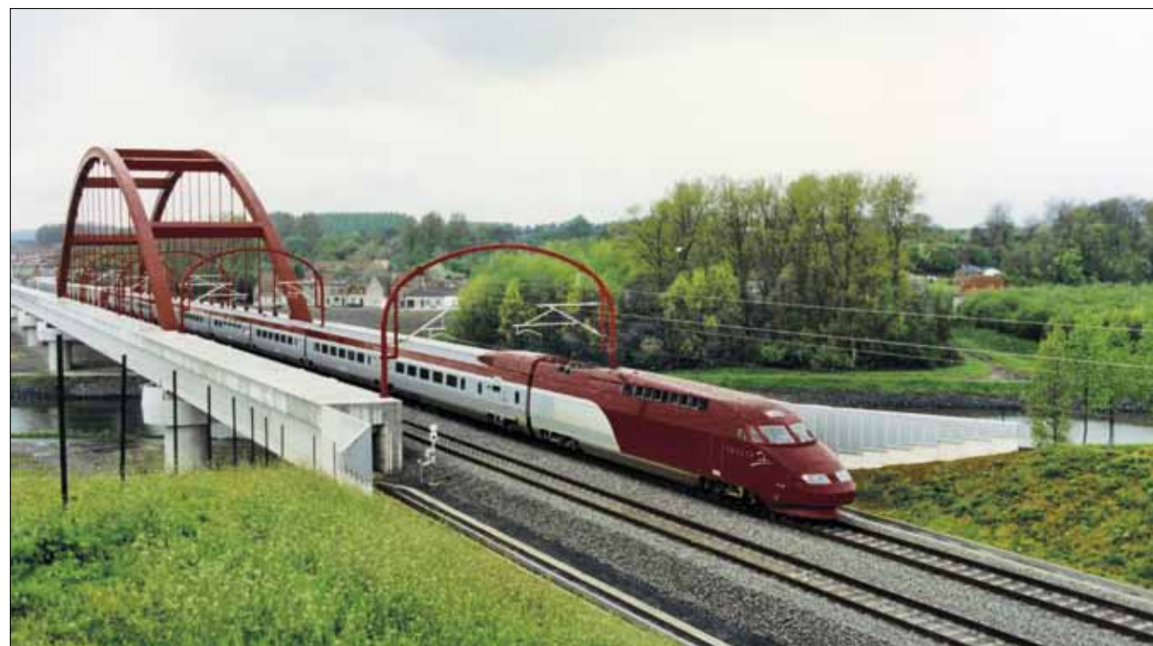
▲ ► Het viaduct van Antoing (438 meter) overbrugt de Schelde
