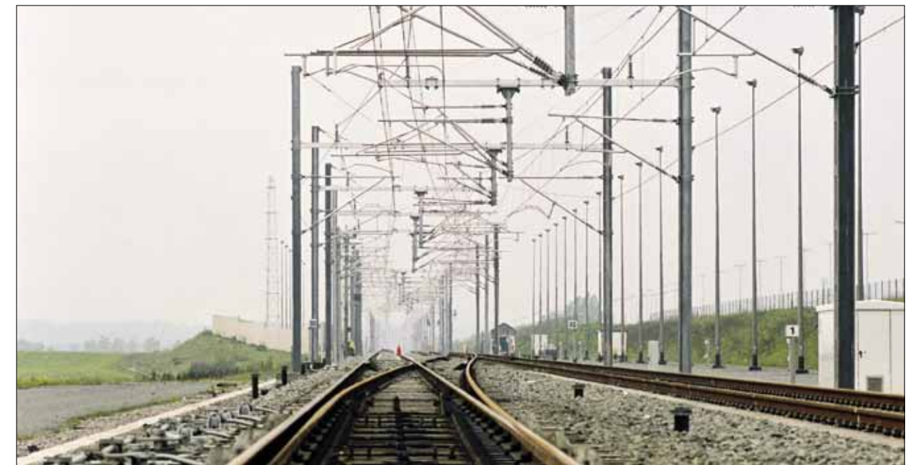
▼ De elektrische spanning voor de HST's bedraagt 25.000 Volt wisselstroom
