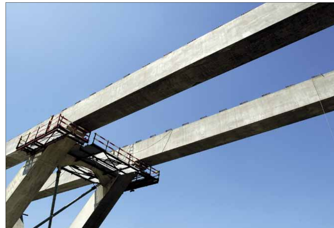
▲ ► De bouw van het viaduct van Battice in detail
