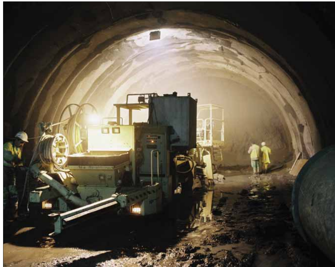
▼ Tijdens de bouw van de Soumagnetunnel maakten de arbeiders een voortgang van 80 meter per week
