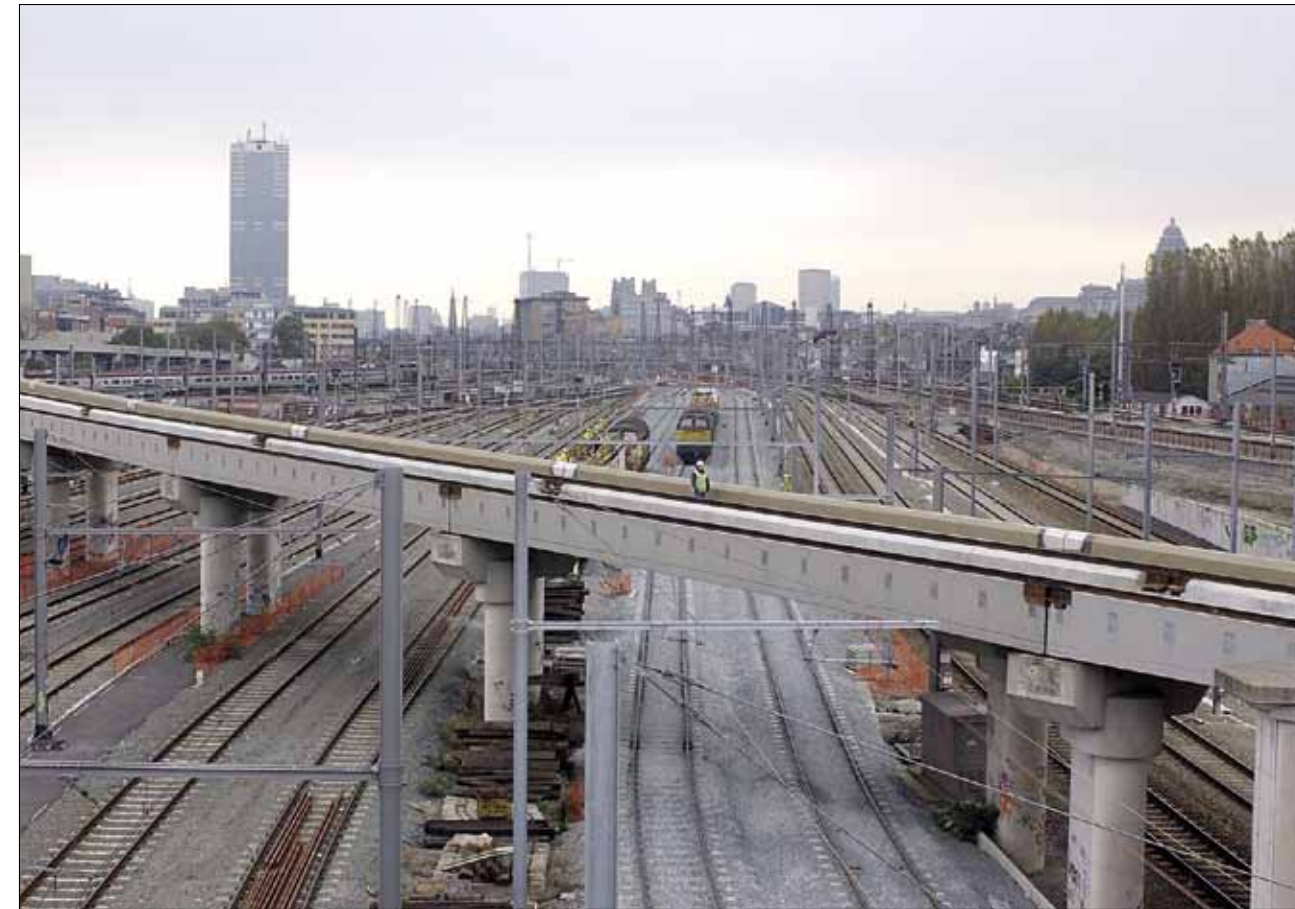
▼ De HST's kunnen de hoofdsporen van het station kruisen dankzij het viaduct van Brussel-Zuid
