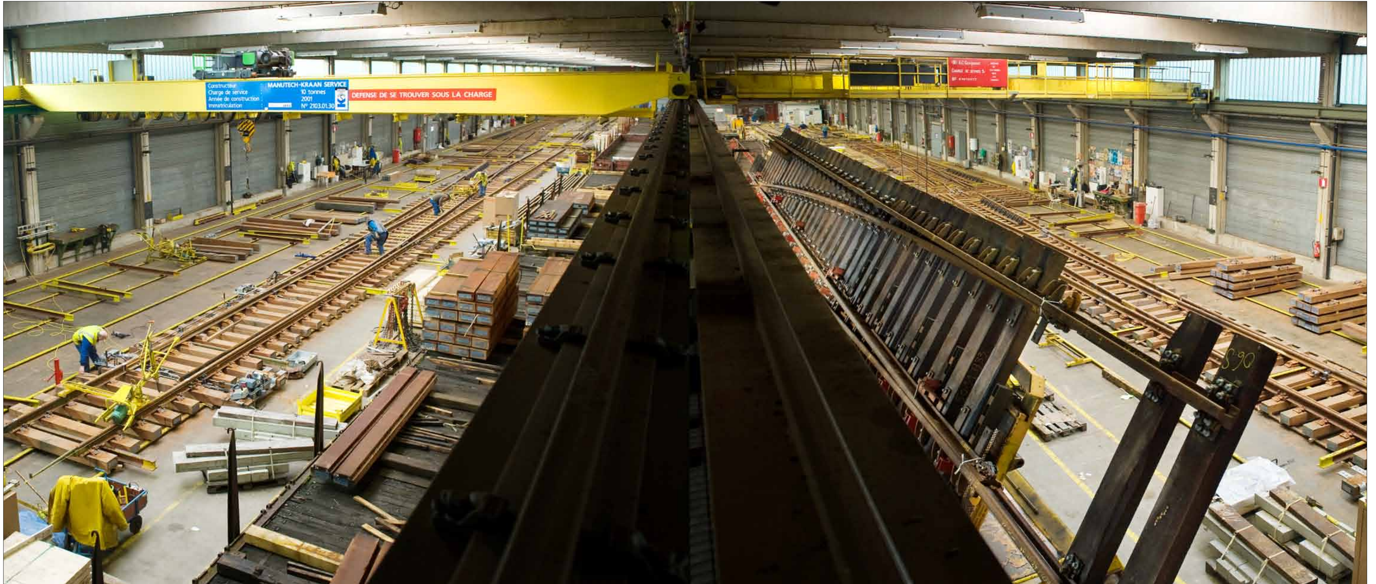
▲ Montage van spoortoestellen in de werkplaats van Infrabel in Bascoup
