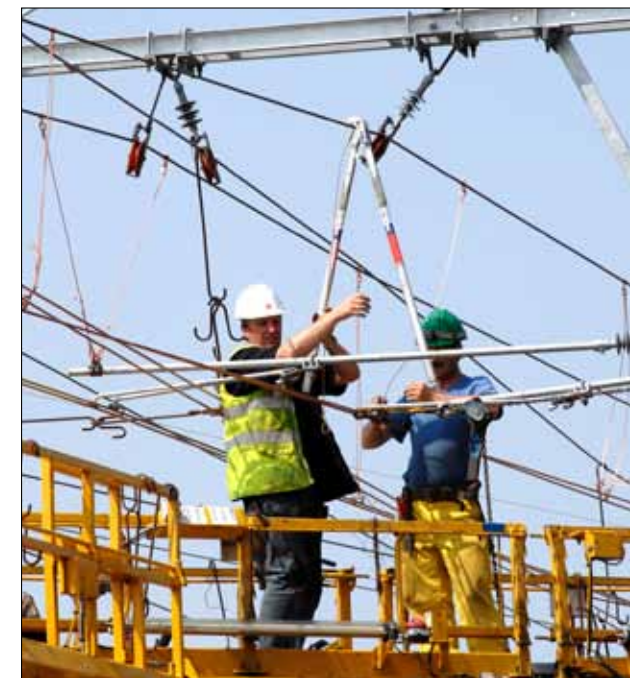
▼ De ploegen van Infrabel werken aan de bovenleiding
