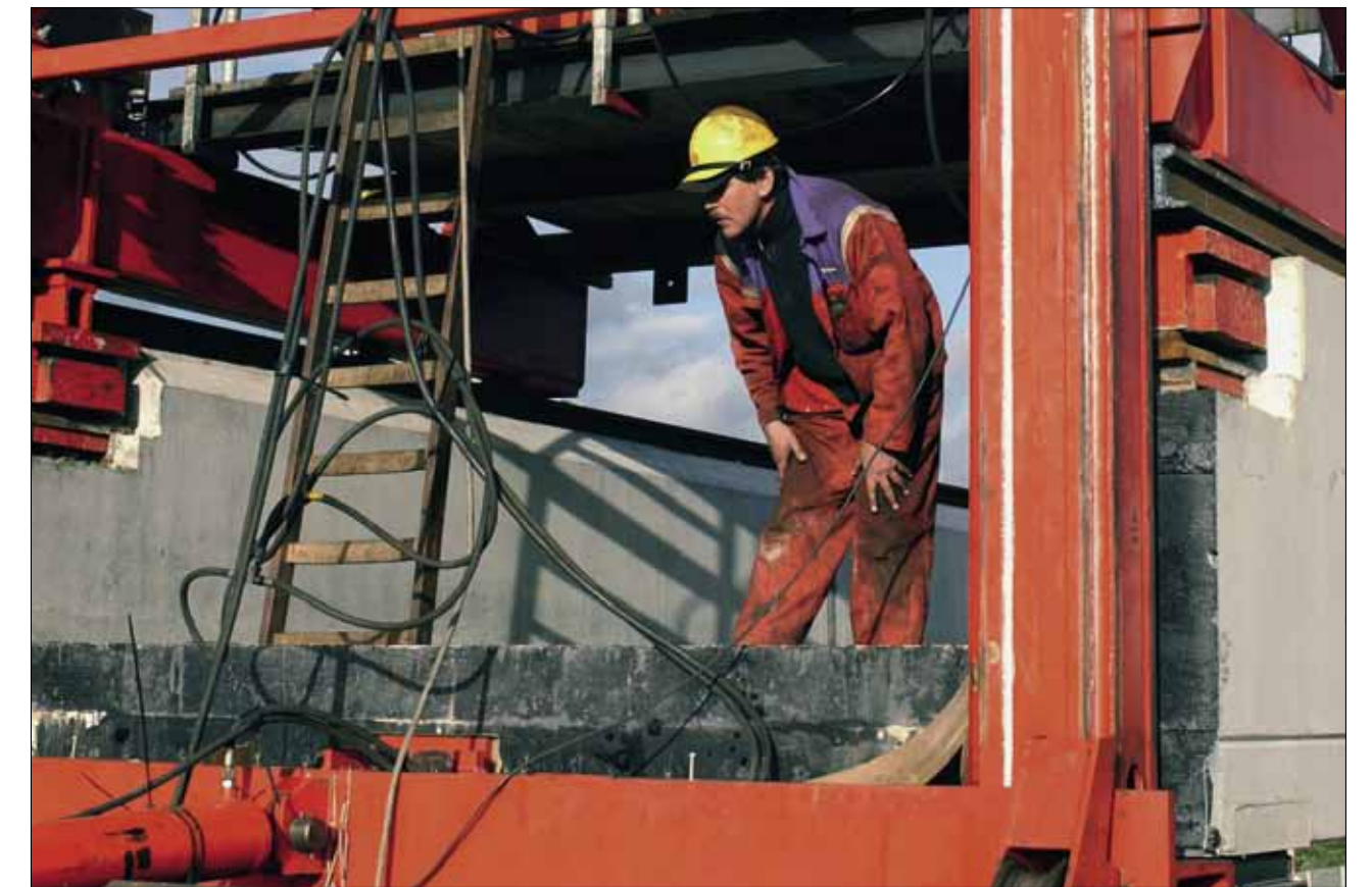
▼ Aanleg van de boogbrug over het kanaal Brussel-Charleroi
