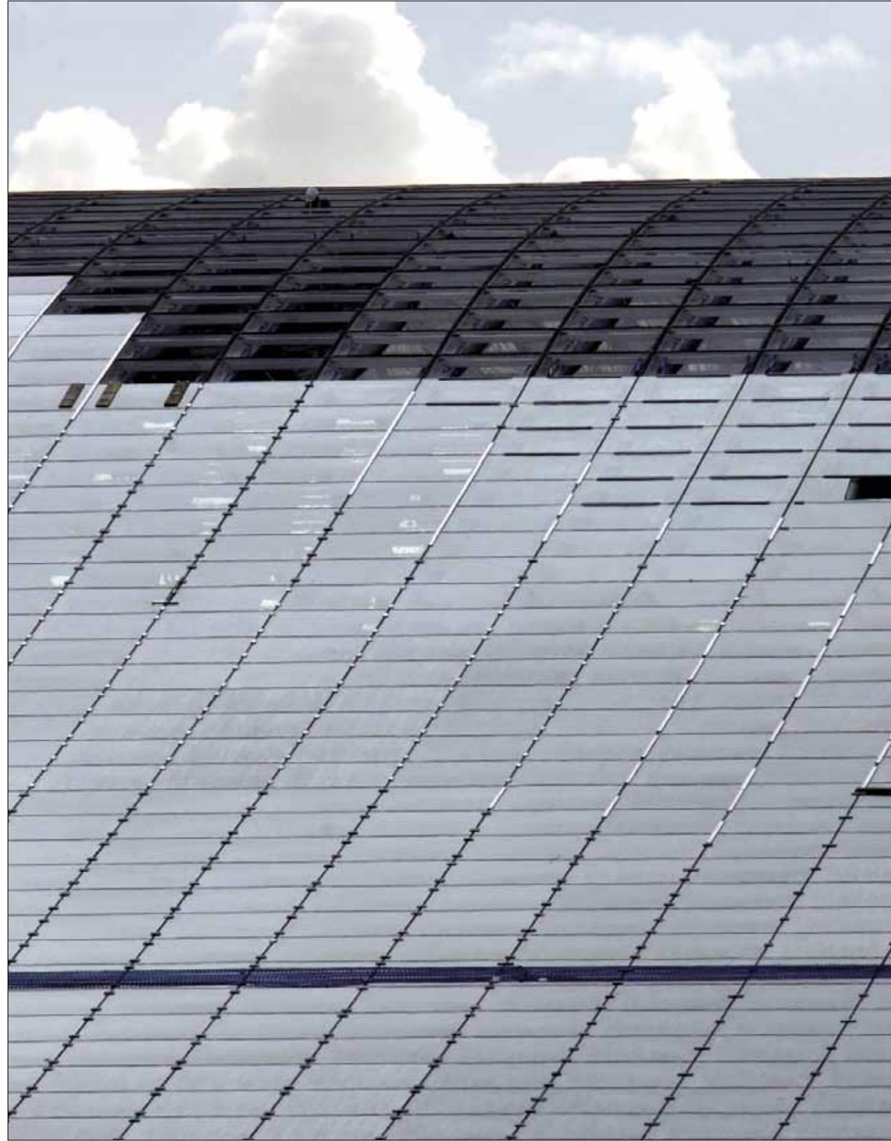
▼ De glasmakers plaatsten meer dan 32.300m 2 glas op de koepel van het station
