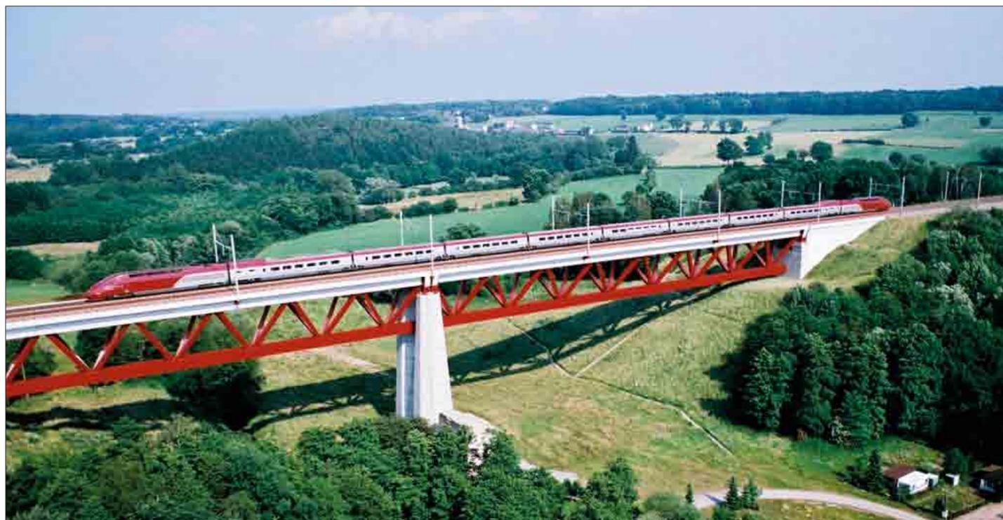
▲ ► Le viaduc de Hammerbrücke est soutenu par un pilier central de 30 mètres de haut
