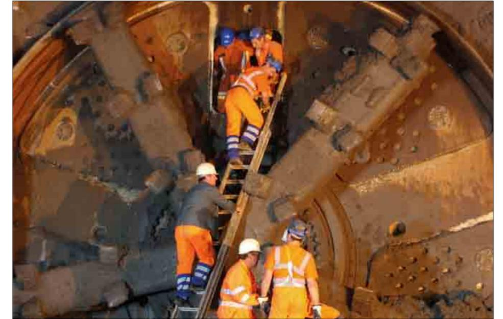
▲ ◀ Un gigantesque tunnelier, muni de deux boucliers de forage, a percé les deux pertuis du tunnel
