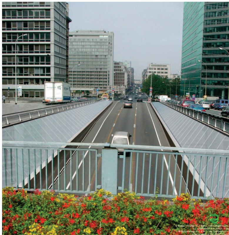
Afgewerkte uitgang van de Wettunnel
