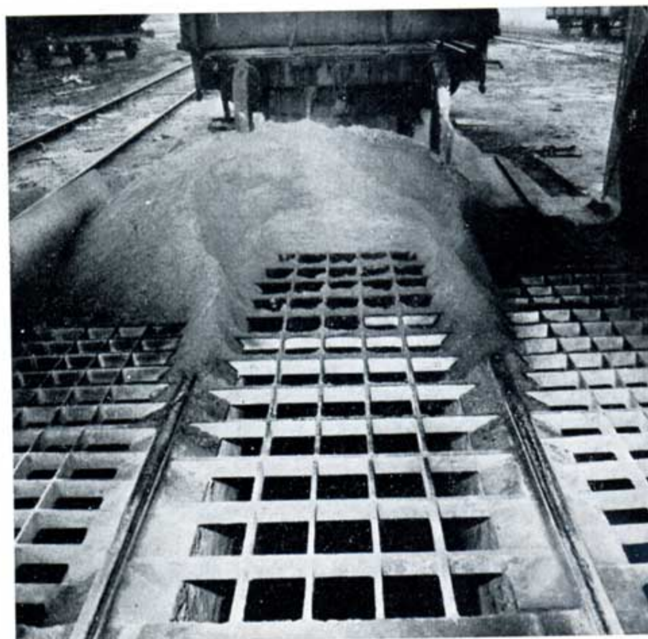
Figures 1-2 Un culbuteur de wagons utilisé à l'usine à claveaux de la S.A. des charbonnages d'Helchtren-Zolder. (Déchargement de sable). (photos Putman)
