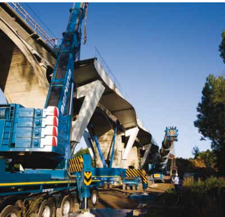
Le viaduc de Pede à Dilbeek
