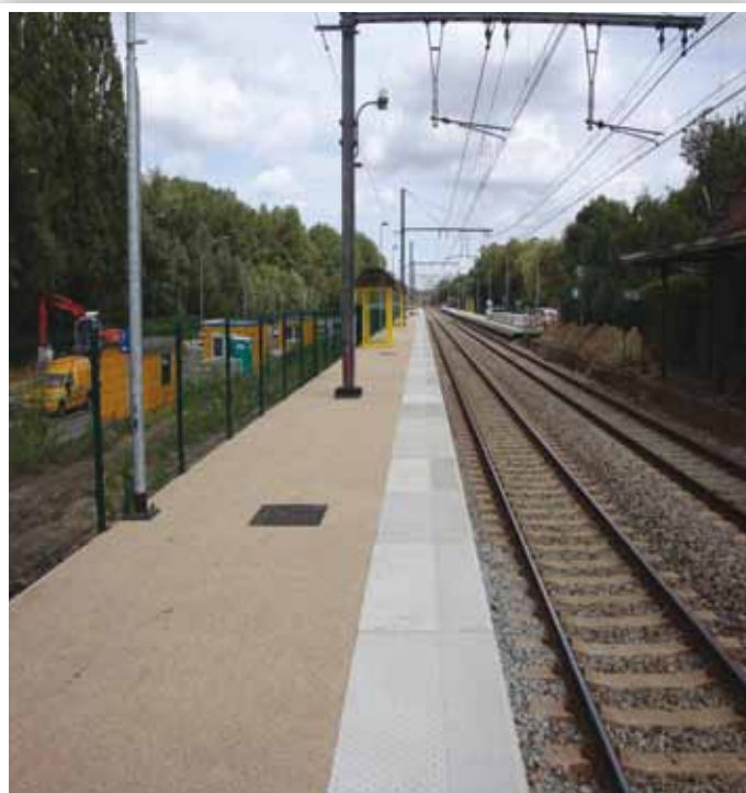
Un nouveau quai rehaussé à Hoboken-Polder
