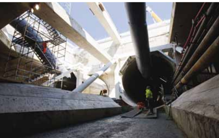
Le tunnel ferroviaire du Liefkenshoek
