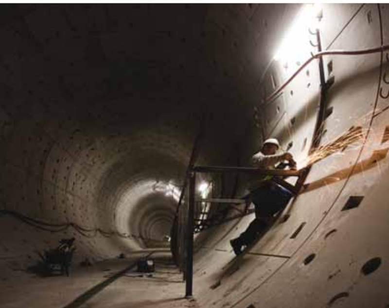
Le tunnel passant sous Brussels Airport
