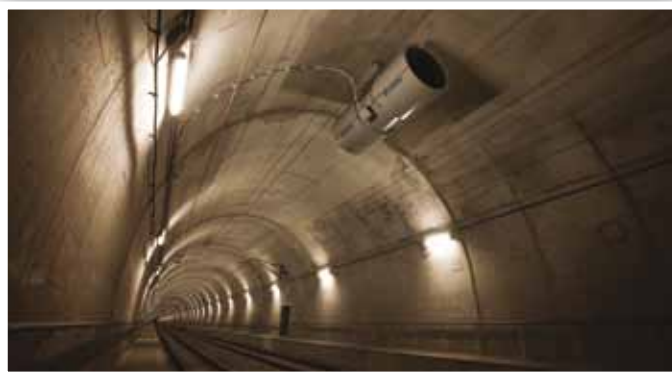
Le tunnel de Soumagne (branche Est)
