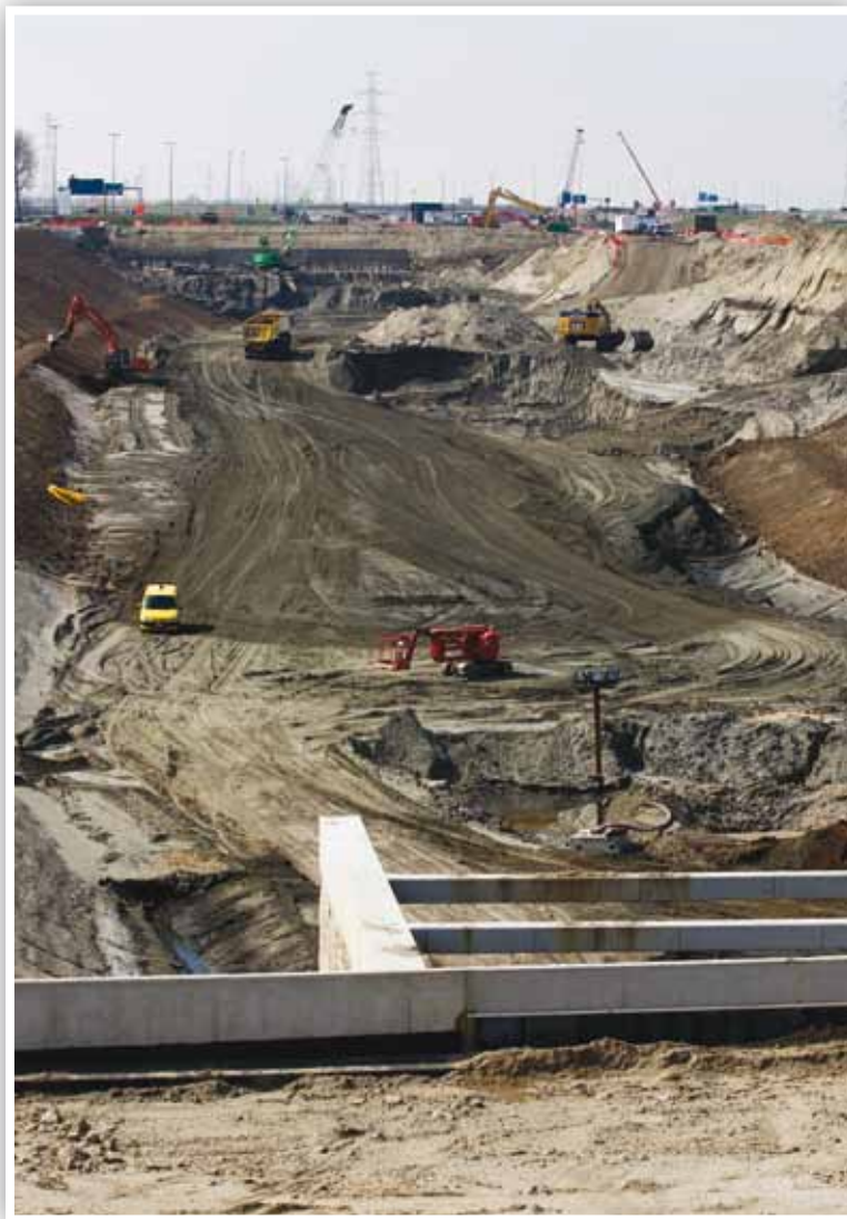
La rampe d'accès au tunnel de Beveren
