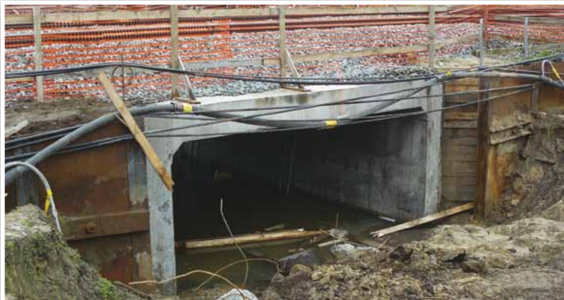
Un tunnel remplace un passage à niveau à Hansbeke
