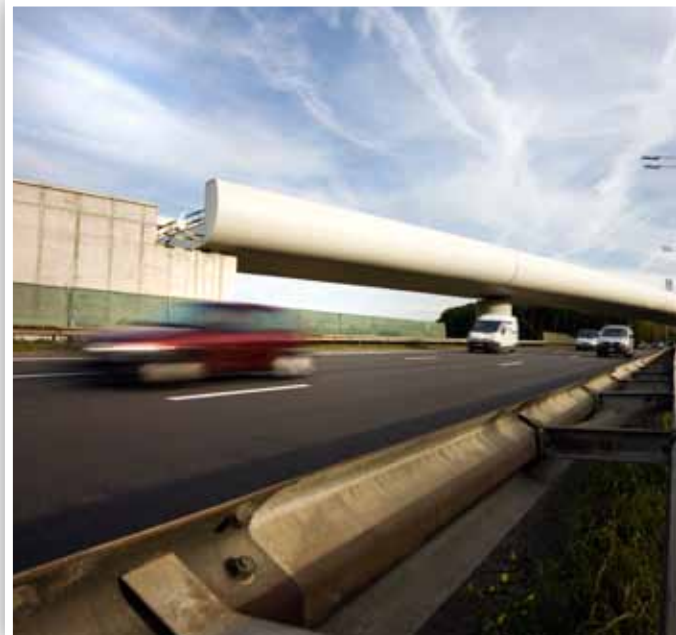
Le pont sur l'autoroute E19 à Zemst
