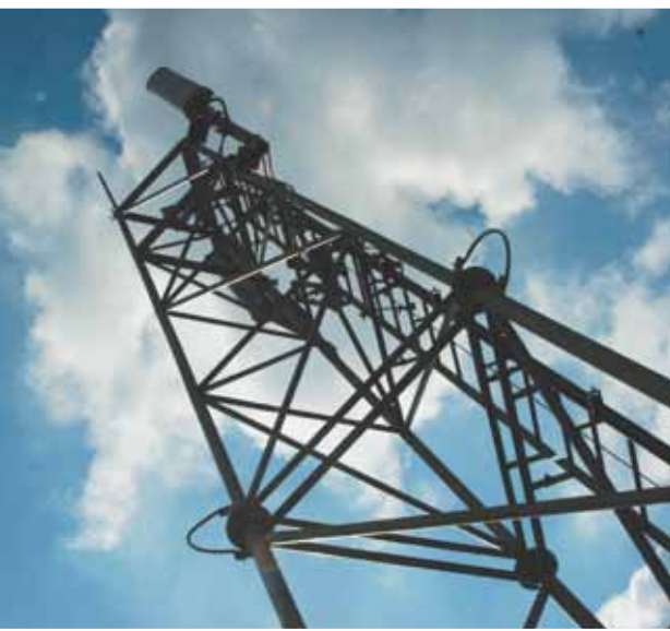
Un pylône GSM-R
