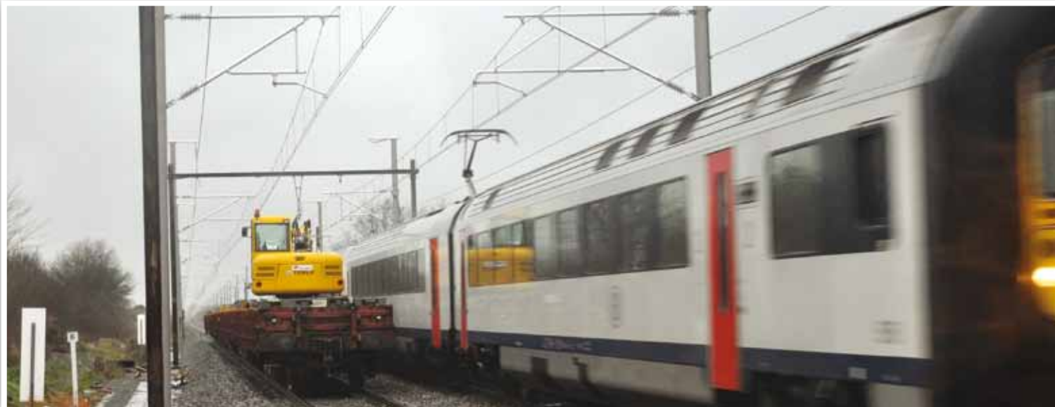
Les travaux à la caténaire à Sterpenich
