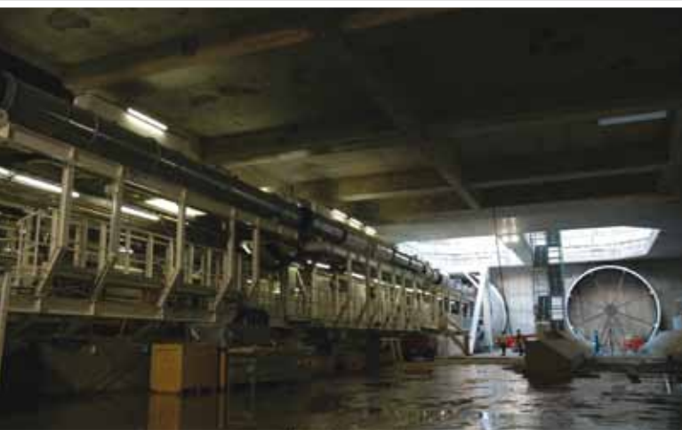
Le tunnelier utilisé pour creuser le tunnel du Liefkenshoek
