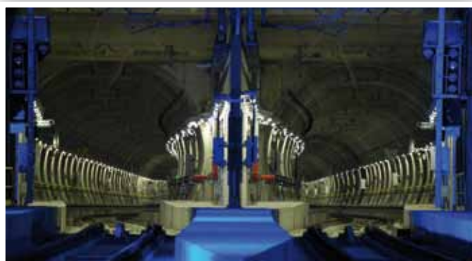
Le tunnel sous la gare d'Anvers (branche Nord)
