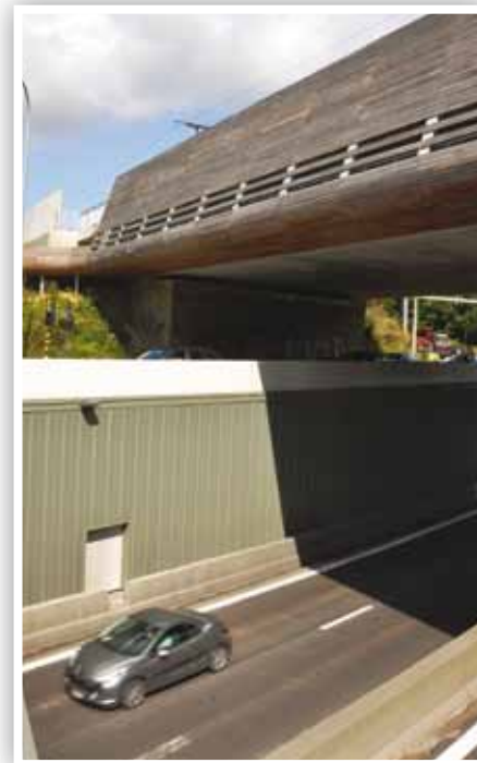
La passerelle qui enjambe le carrefour de Groenendael
