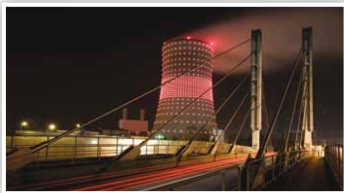
Le Pont d'Humanité à Drogenbos (branche Ouest)
