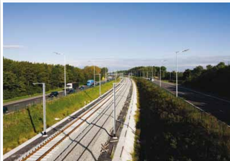
La pose des voies sur la berme centrale de l'autoroute E19
