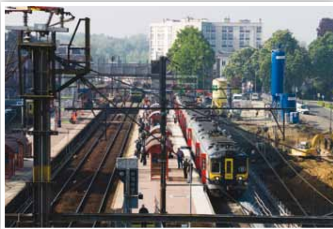
La gare RER de Nivelles
