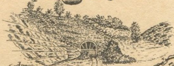
Tunnel à Grotte en Construction
