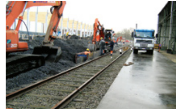
De bouw van het productiecentrum is gestart.
