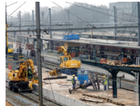
Tijdens de werken blijft het station operationeel.
