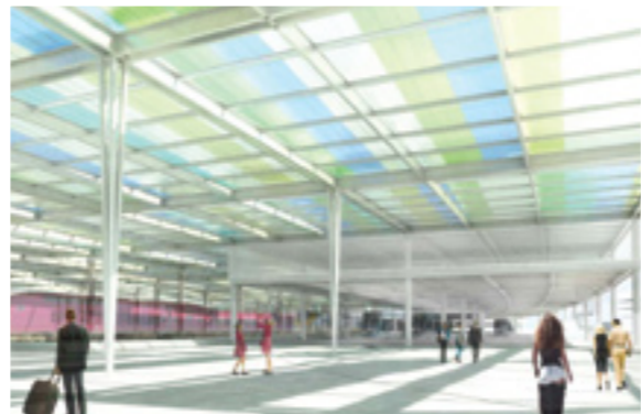
Meer dan 10.000m² lichtdoorlatende fotovoltaïsche zonnepanelen zorgen voor heel wat energiebesparingen.
