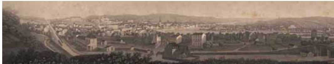
Eerste Guillemins-station en hellend vlak dat het plateau van Haspengouw met de Luikse vallei verbindt.
