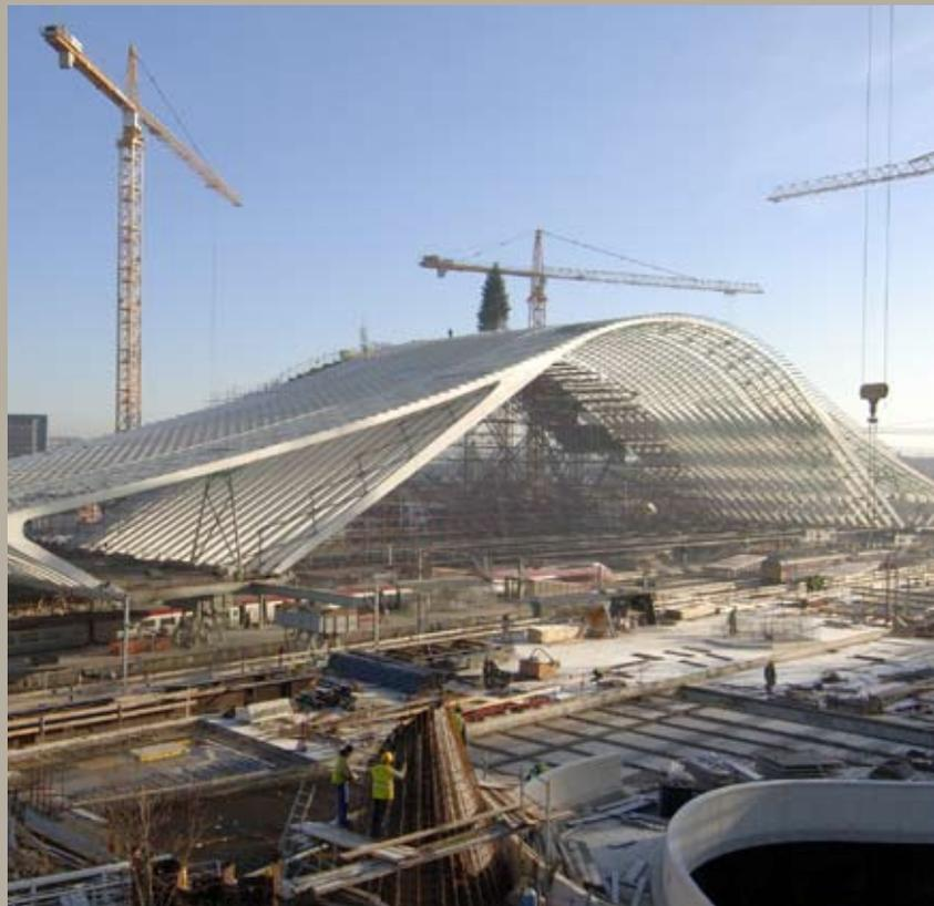
La construction de la voûte, poussée au-dessus des voies.
