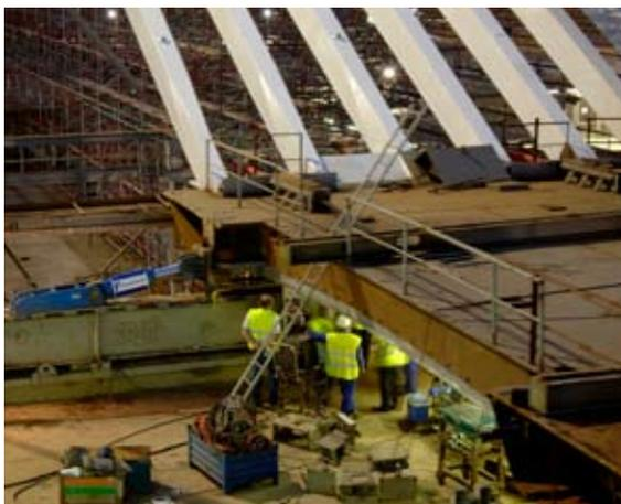
Les vérins hydrauliques poussent les arcs au dessus des voies.
