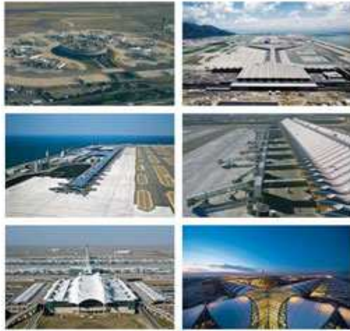
Terminal 1 de l'aéroport de Paris-Charles de Gaulle, conçu par Paul Andreu, 1974. © Sébastien Oberlin 2014 Le terminal des passagers de l'aéroport international Ngurah Rai (Dagur), conçu par Pierre Ponce, 1974. © Pierre Ponce / Studio Meda / Meda / 1974
