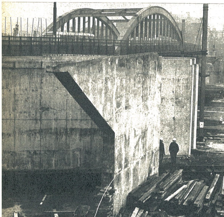
Pont de la Villette met, op de voorgrond, de landhoofden van de toekomstige brug
