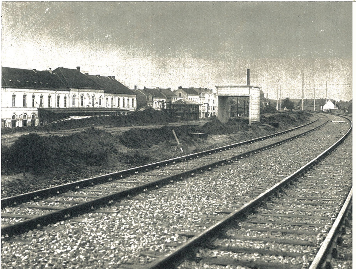
Aanpassingswerken aan de bedding van het nieuwe station St.-Niklaas.
