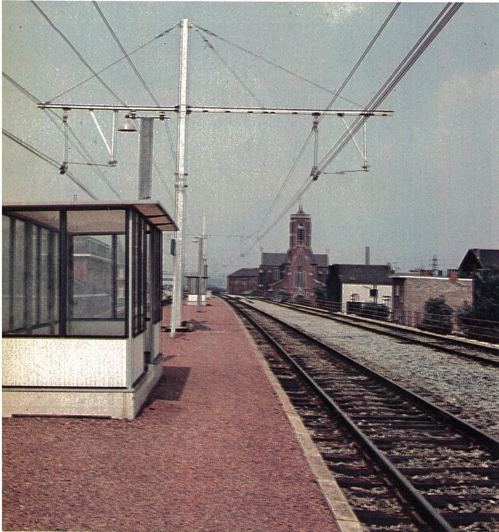
Nieuw perron te Flémalle-Grande.
