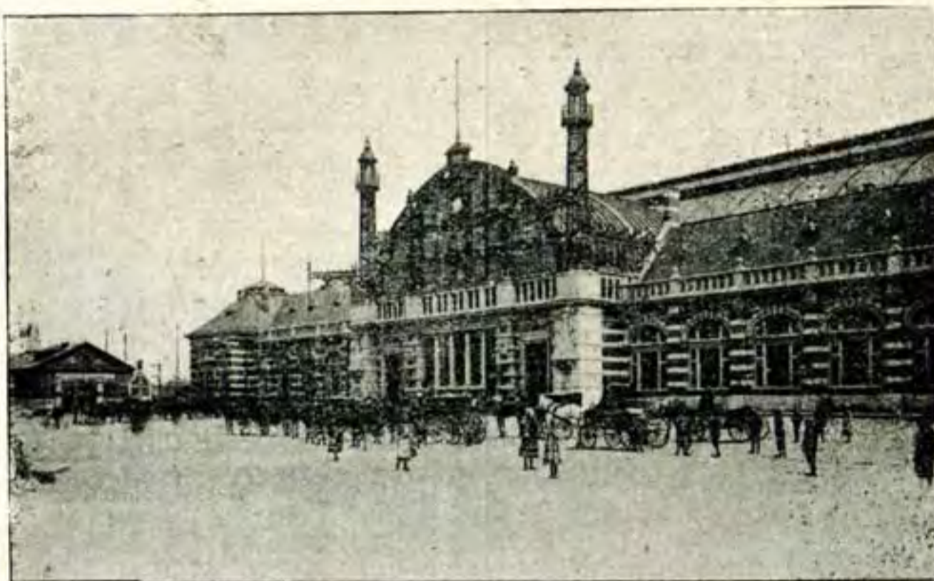
Station de Malines, remplaçant les planches de 1835
