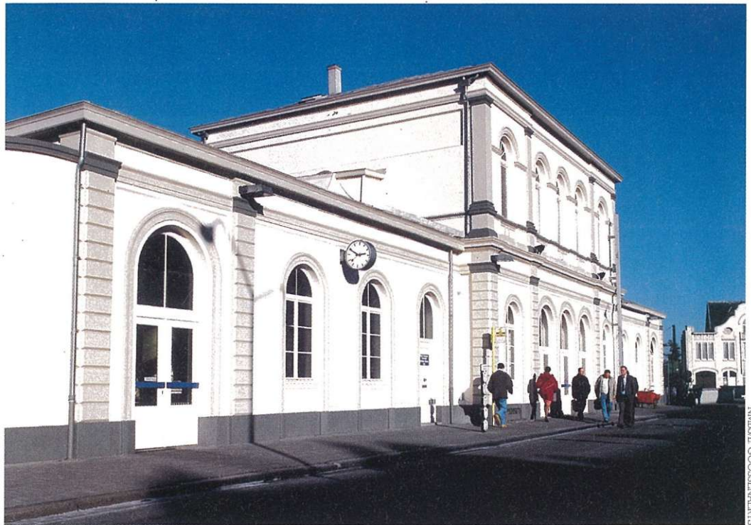
BUITENGEVEL STATION LIER
