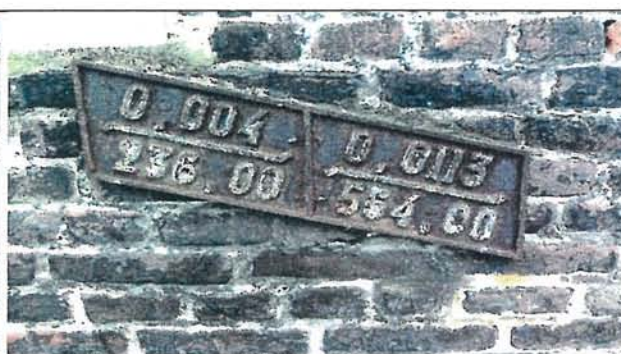
Indicateur de pente, situé à Anzin-Centre, partie gauche 0,004 millièrne et 236 mètres de pente prolongée, partie droite 0,0113 millièrne et 564 mètres de pente prolongée (photo D. Tasbille)
