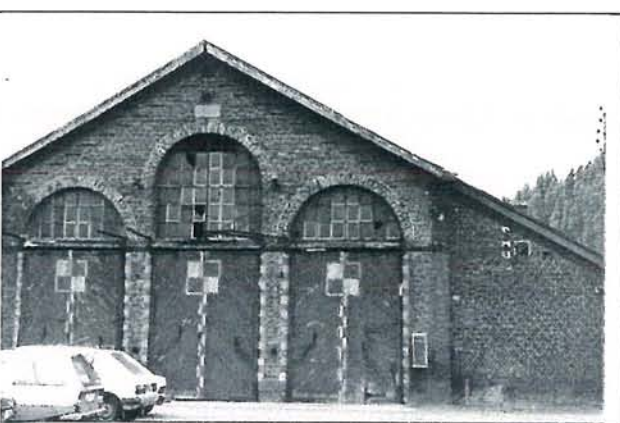
Dépôt de Vieux-Condé en 1980 (photo G. Grépier)
