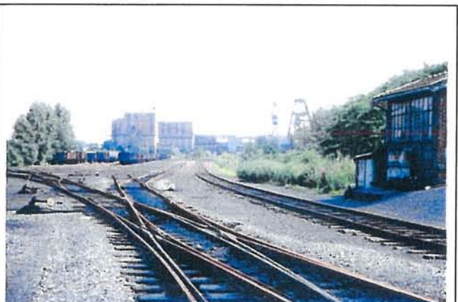
Voies ferrées à la fosse Ledoux de Condé sur l'Escaut (photo G. Grépier)
