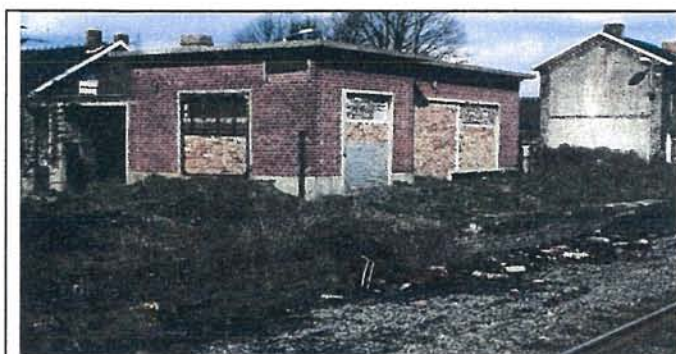
Point d'arrêt du Moulin à la Bleuse-Borne à Anzin, photographié en 1980 avant démolition (photo G. Grépier).
